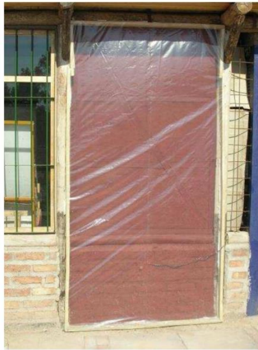
Figura 5. Fotografía del muro de quincha con el sistema incorporado y cubierta adosada (Mercado y Esteves, 2006, p. 5) .
