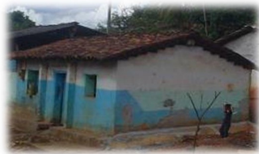
Imagen 17 "Viviendas de los B.C. de Colotepec".
