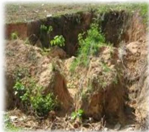
Imagen 43. Erosión en cárcavas en el "Cerro del Colochi".
