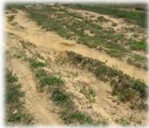
Imagen 42. Erosión en surcos "Cerro del Colochi".
