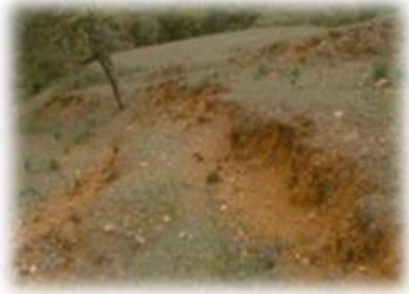
Imagen 44 Degradación de suelos.
