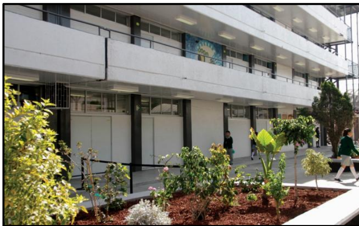
Figura 1.65 Muros de cortante en la escuela "Dr. Manuel Gutiérrez Nájera".
