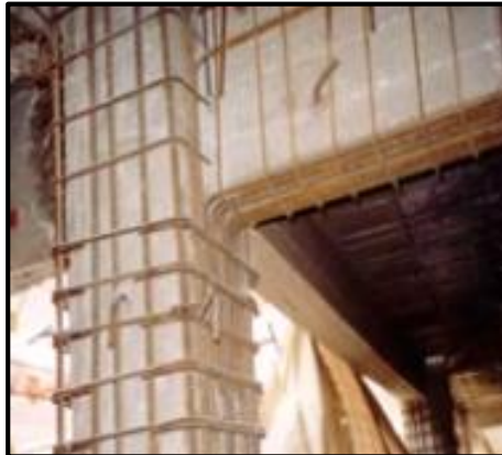
Figura 1.50 Armado para el encamisado de concreto. (Sísmica Adiestramiento)
