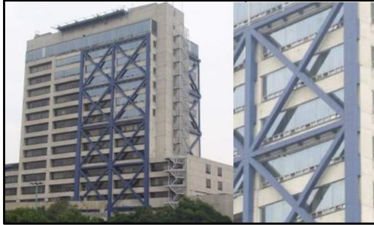
Figura 1.47 Contraventeo externo conectado a la viga y losa. (AF-CENAPRED)
