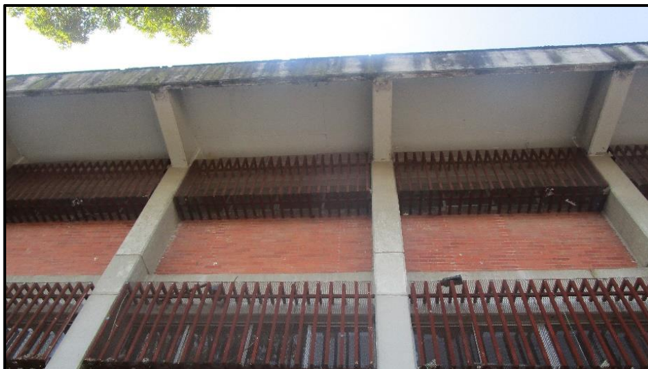
Figura 3.21 Daños preexistentes, deterioro del concreto debido a escurrimientos pluviales. (DE-DICYG, 2018)
