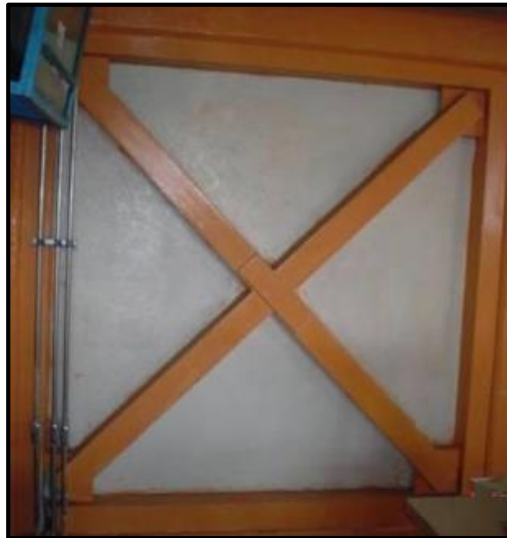
Figura 1.58 Contraventeo conectado a un muro de concreto. (CICM-SMIE, 2018)
