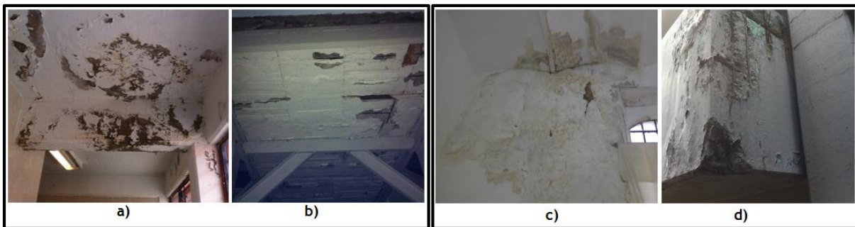
Figura 1.38 Daños debido a escurrimientos pluviales en losas, trabes y columnas en las escuelas a) "Juventino Rosas", b) "Matro. José Vasconcelos", c) "Escuela de Participación Social No. 6" y d) "Gral. Heriberto Jara". (CICM-SMIE, 2018)
