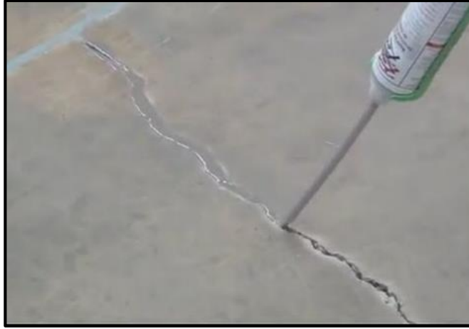
Figura 1.59 Inyección de resina en las grietas del muro. (Aragosaurus.com)
