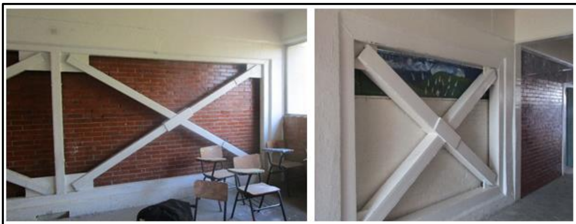
Figura 1.63 Detalle de contraventeos en el interior de la escuela "Celestino Gorostiza". (DE-DICYG, 2018)
