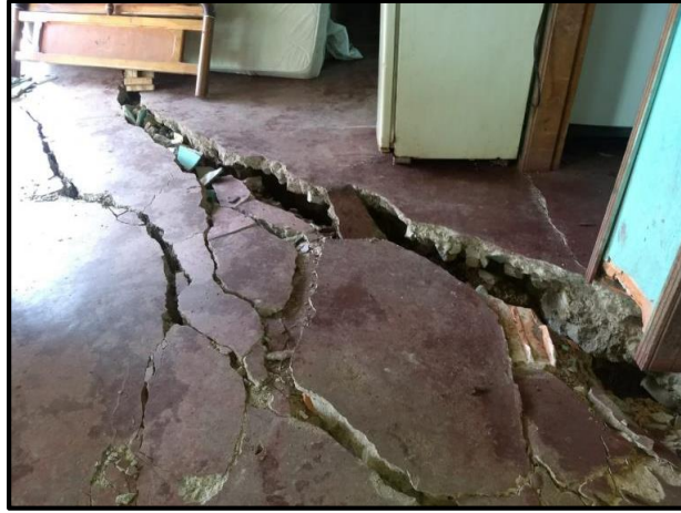
Figura 1.25 Apertura de falla regional. (CICM-SMIE, 2018)
