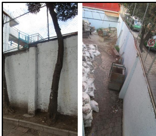
Figura 1.66 Contrafuertes en muros perimetrales, escuela "Rafael Ramírez". (DE-DICYG, 2018)
