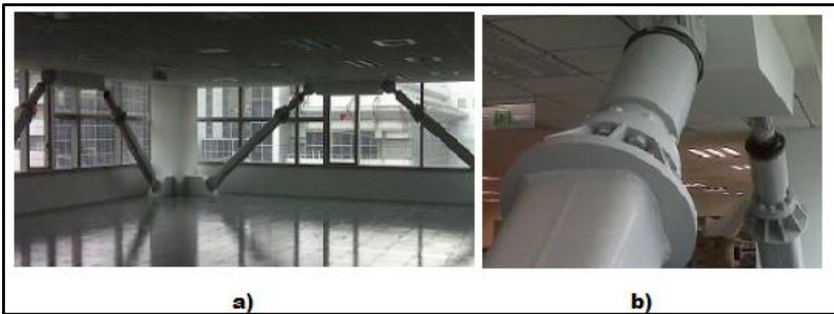
Figura 1.51 a) Amortiguadores hidráulicos; b) Detalle de un amortiguador hidráulico. (Foreva, 2013)
