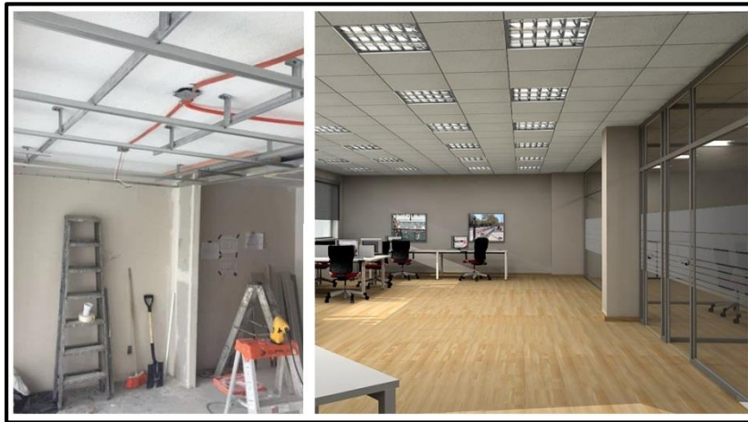
Figura 1.61 Habilitación de un inmueble después de un sismo. (ARQHYS)
