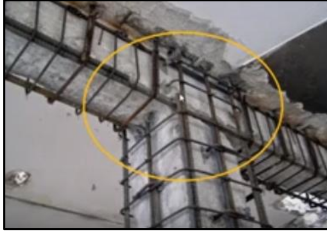
Figura 1.57 Encamisado de unión viga- columna de concreto reforzado. (Sísmica Adiestramiento)
