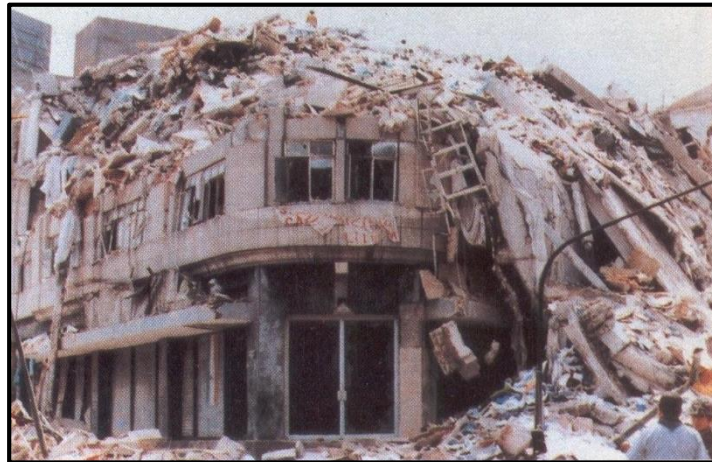
Figura 1.24 Colapso de un edificio de esquina, por efectos de torsión, durante el sismo de 1985 (DE-DICYG, 1985)
