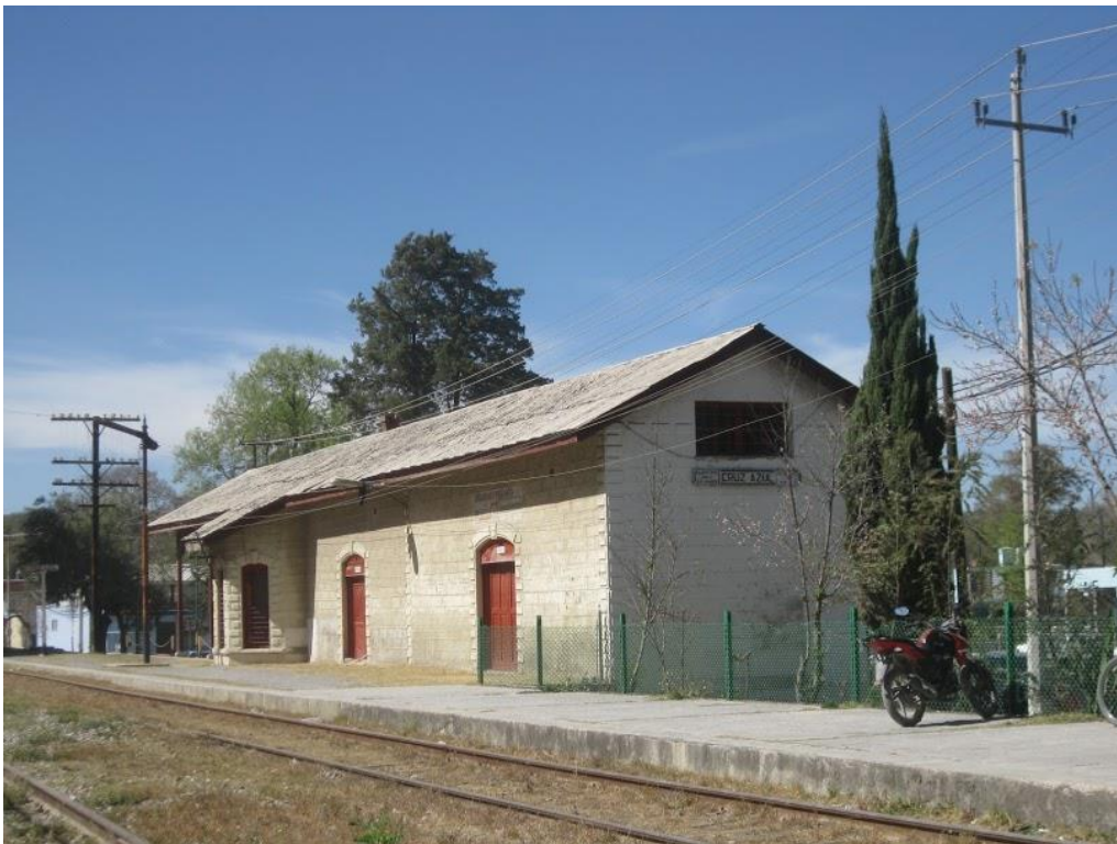
Fotografía 3.5 Antigua estación del ferrocarril de Cruz Azul
