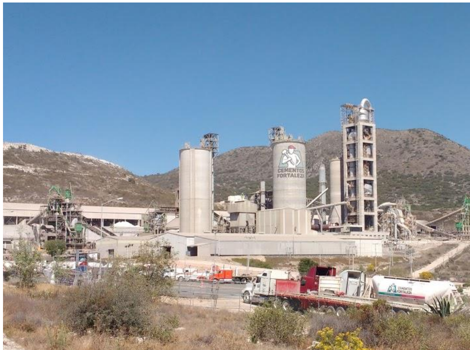
Fotografía 3.17. Cementos Fortaleza planta El Palmar.
