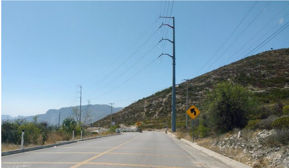
Fotografía 3.18. Carretera y líneas de tensión de Cementos Fortaleza El Palmar
