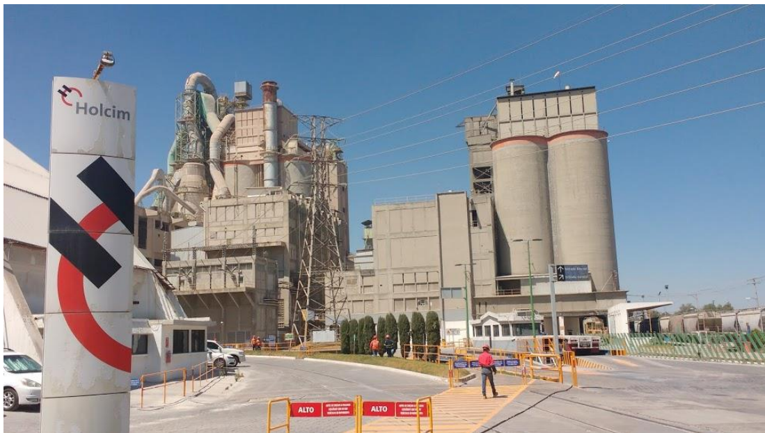
Fotografía 3.11. Instalaciones de Holcim México planta Apaxco
