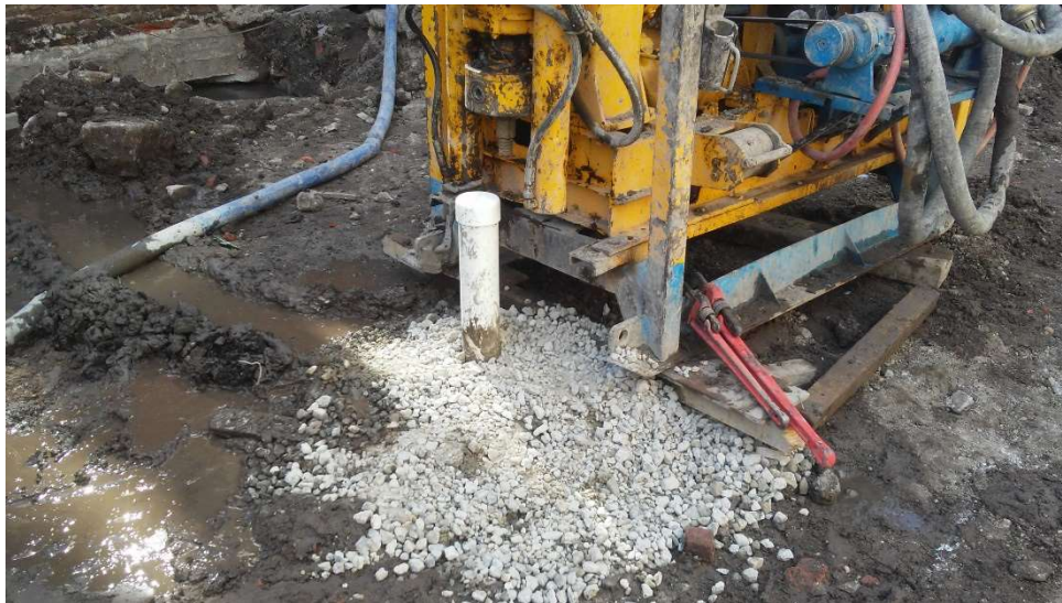
Imagen 10. Hincado de pozo para abatimiento del nivel freático.
