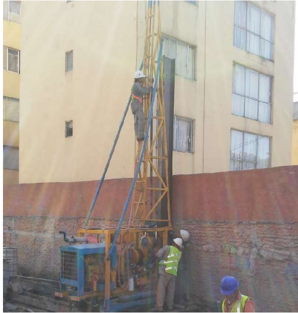
Imagen 12. Hincado de viguetas para estructuración de muro Berlín.
