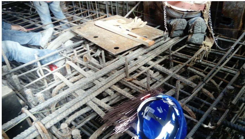
Imagen 16. Trazo de ejes de acuerdo con el proyecto, así como la correcta nivelación.
