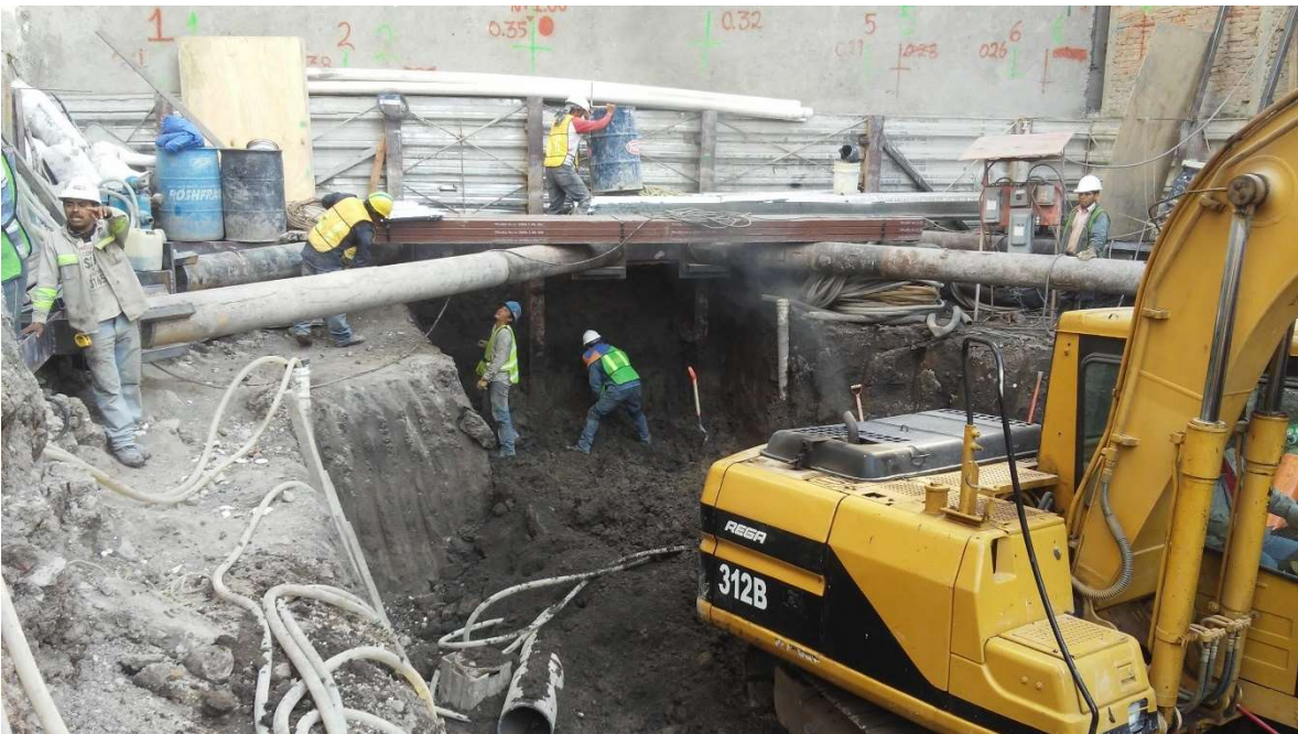
Imagen 13. Armado de muro Berlín, así como la colocación de troqueles para contrarrestar los empujes horizontales.
