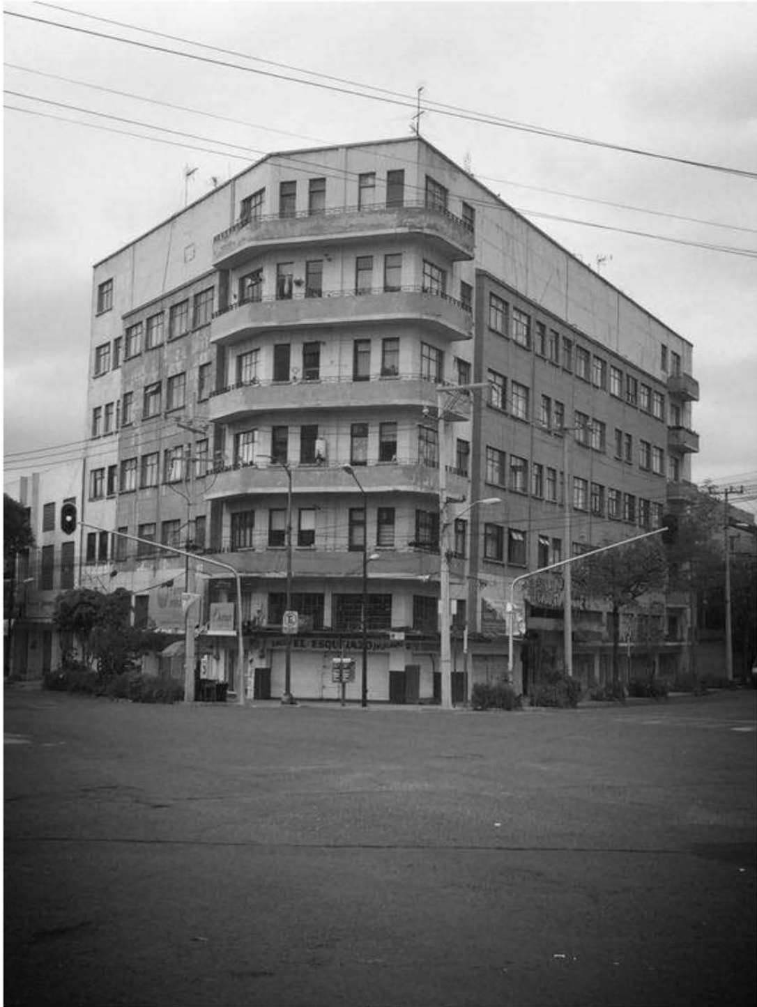
Imagen 6. Edificio de departamentos en abandono Diagonal 20 de noviembre 260, Colonia Obrera. Fuente: Revista México de Ayer.
