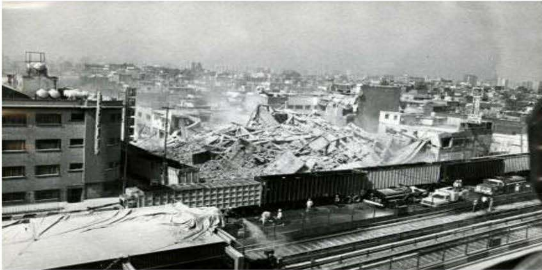
Imagen 5. Fotografía de los derrumbes ocurridos en el sismo de 1985 sobre la Calzada San Antonio Abad. Fuente: Periódico "El Universal".
