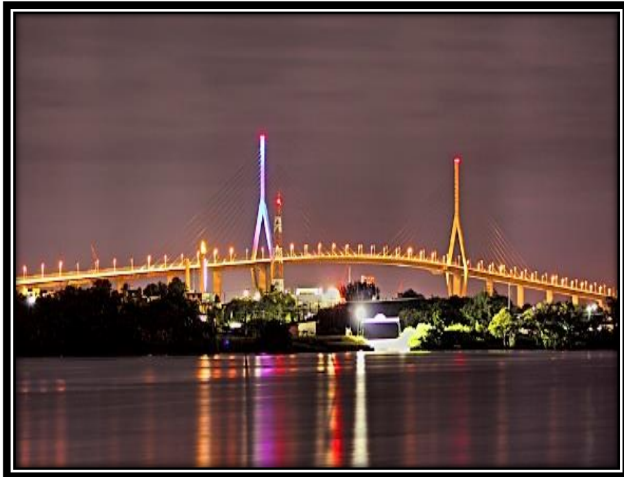
Imagen No. 4. Puente Coatzacoalcos II
