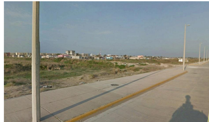
Vista Oeste: (Terreno con viviendas unifamiliares).
