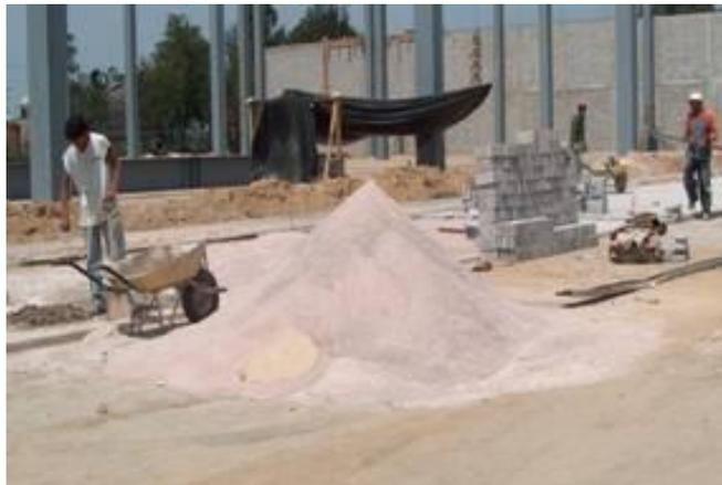
El espesor de arena no compactada variará entre 4 y 5 cm. Obteniendo un espesor original de 3 a 4 cm. Una vez colocados los adocretos y vibrando el pavimento.
