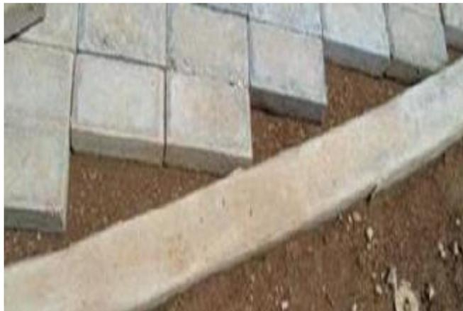
5. Con frecuencia es necesario cortar los adoquines colindantes a la guarnición, los canales de drenaje, o alrededor de registros. Es fácil hacer esto, de preferencia con una cortadora con disco de diamante, o bien con un cincel ancho y un martillo.
