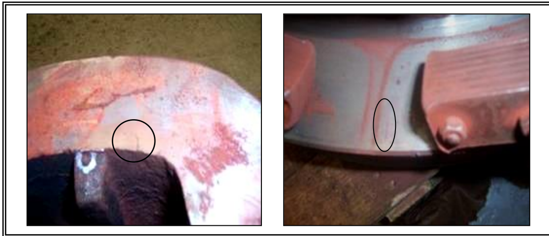
Figura III.1.3.1.1 Ejemplo de indicaciones lineales no conformes encontradas durante la inspección por Partículas Magnéticas.
