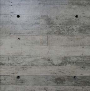
Concreto gris aparente Acabado enduelado
