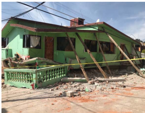
Img. 1 Losa fracturada apuntalada O.O.R
