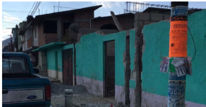
Img. 10 Vivienda colapsada en proceso de reconstrucción
