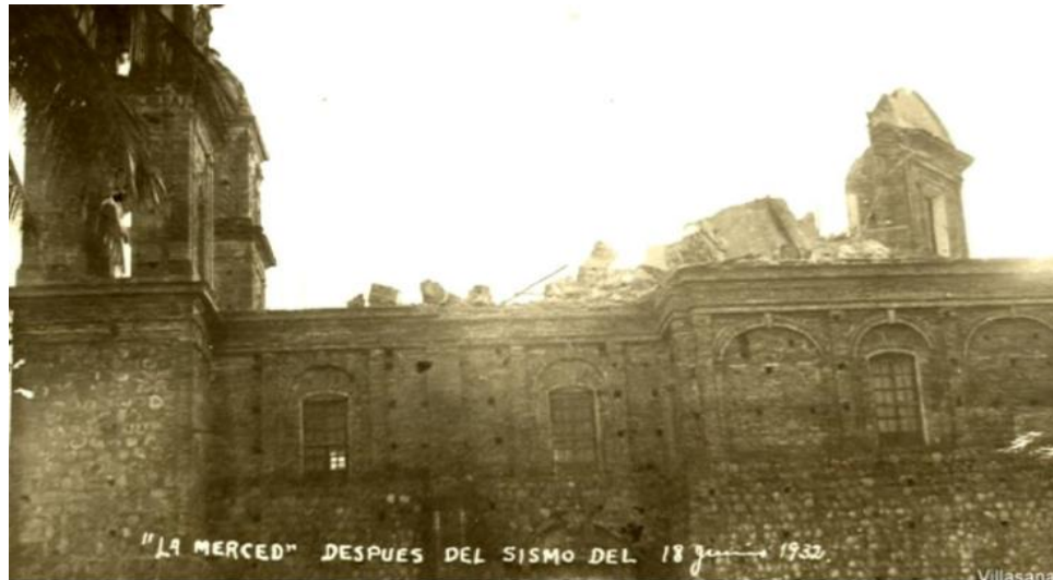
Figura 1.3. Construcción dañada por el sismo de 1932 (Reporte del SSN).
