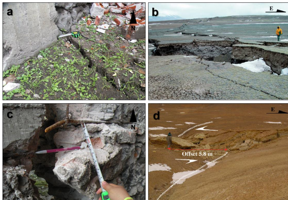
Figura 6.6. Fotografías de comparación entre la falla Kunlún y las grietas de Zacatepec, en a) y b) se observa la apertura de las grietas en cada zona mientras que en c) y d) se observa desplazamiento lateral izquierdo.
