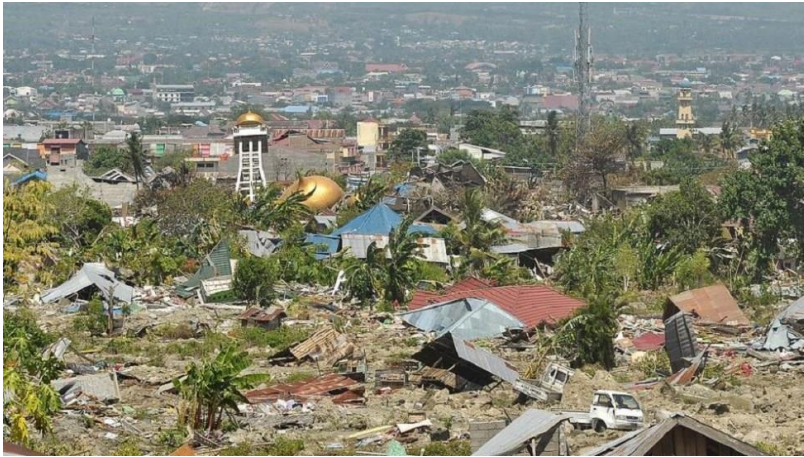
Figura 3.11. Fotografía de los daños ocasionados por efecto de licuefacción posterior al sismo ocurrido en Indonesia en 2018.
