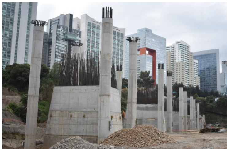
Figura IV-10 Columnas principales para la estación Santa Fe. 66
