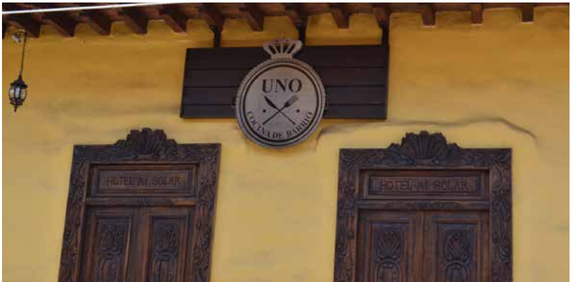
1.6 Fachada de restaurant en el hotel "Mi Solar".
