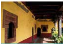
Pasillo del exterior
