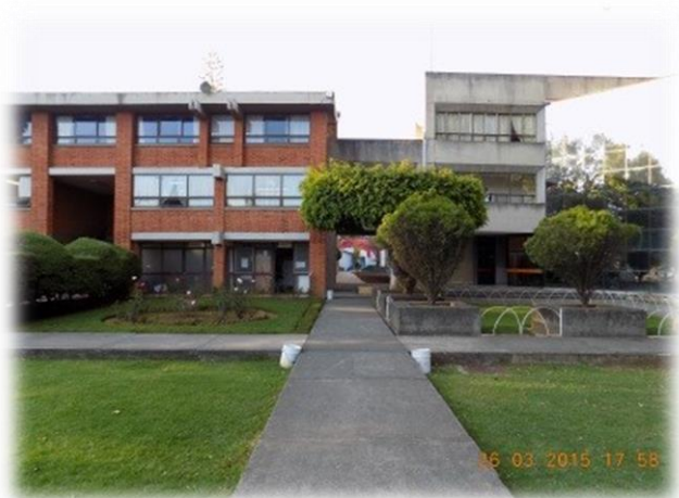
Fachada del Edificio uno y Edificio Central.
