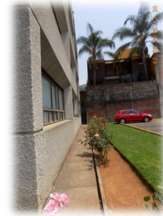
Este es una banqueta adosada a una fachada lateral del edificio Central, junto al Estacionamiento de la puerta dos, que junto a la colindancia genera lo que vulgarmente llamamos "paso de burro", ya que acorta las distancias entre este estacionamiento y los talleres de Arquitectura y Diseño y C.V., Y El Auditorio.
