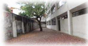
Corredor o pasillo a espaldas del Edificio Central.
