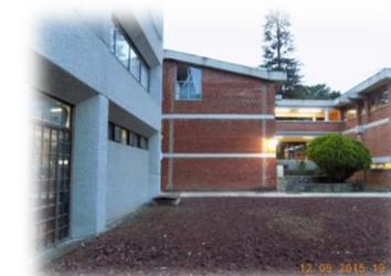
Vista de la fachada posterior del Edificio Central Y de las fachadas posteriores de los edificios 2 y 3
