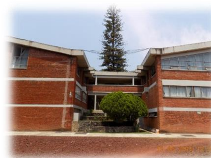
Estos edificios se encuentran en desnivel desproporcionado con el usuario en relación a los mismos edificios vistos en sus patios centrales.
