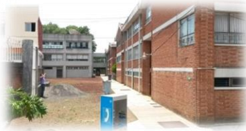
Corredor o pasillo a espaldas de los Edificios 1 y 2, 3 y 4.
