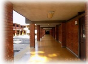
Pasillos de los edificios 1,2,3, y 4.
