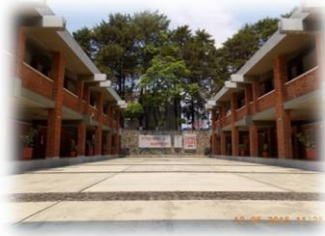
Patios Centrales entre Edificios 1 y 2, 3 y 4, 5 y 6
