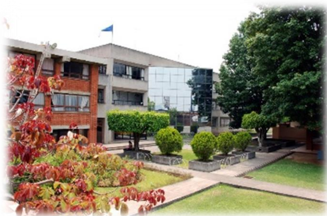
Edificio Central con Muros de Cristal.
