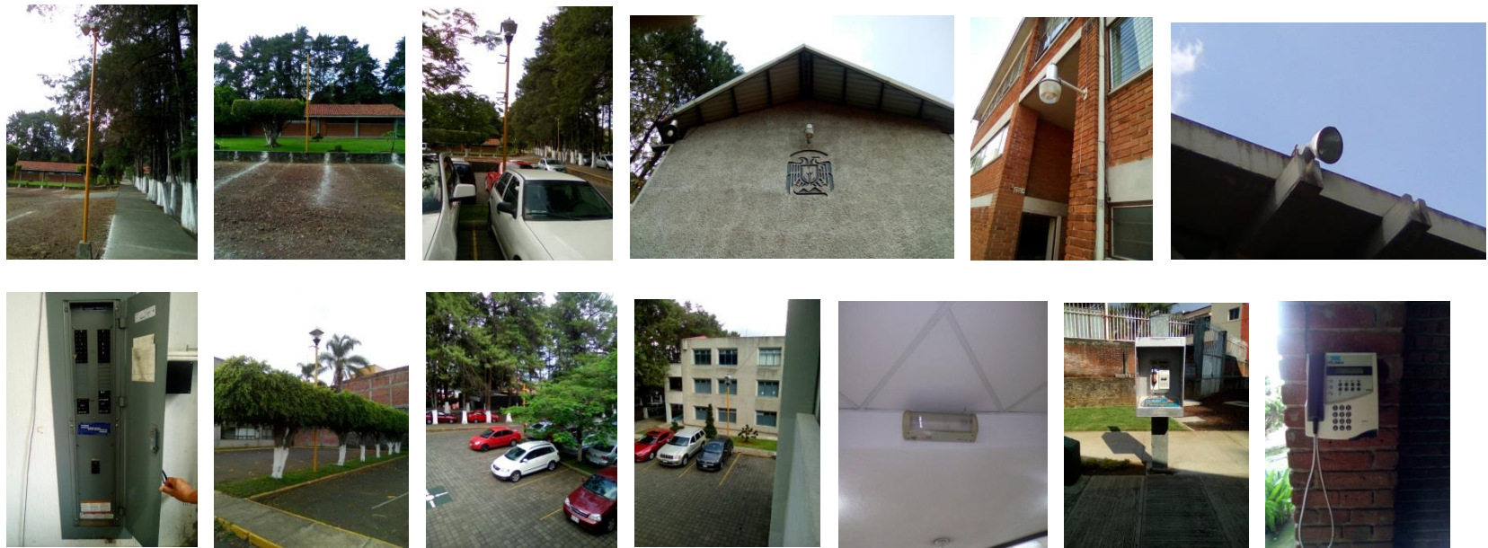
Instalaciones Eléctricas, Alumbrado en interiores y exteriores, lámparas de emergencia. Instalaciones de Teléfonos.
