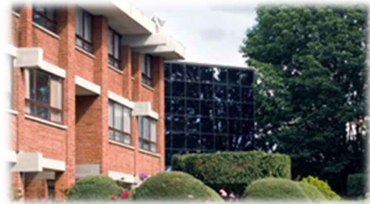
Fachada del Edificio uno y Edificio Central.
