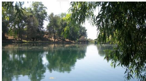
Presa de Caltzontzin
