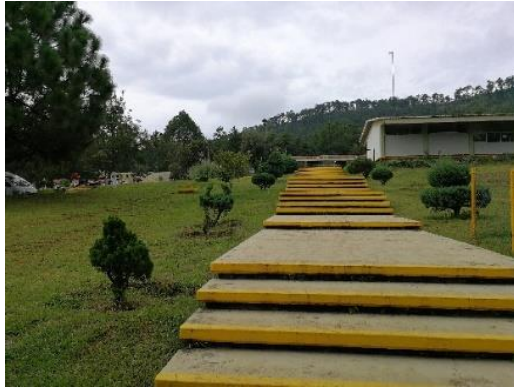
Escaleras que distribuyen a la primera explanada
