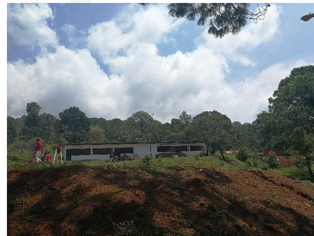
Estado actual nuevo plantel Caltzontzin (agosto 2018)
