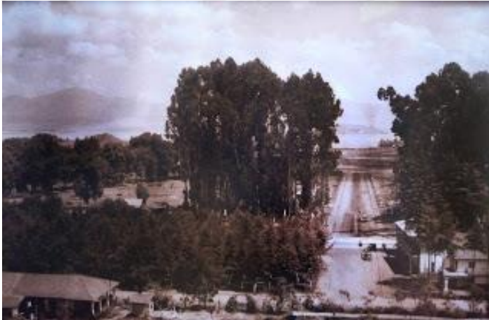
Fotografía de Caltzontzin antiguo de la década de los 50's
