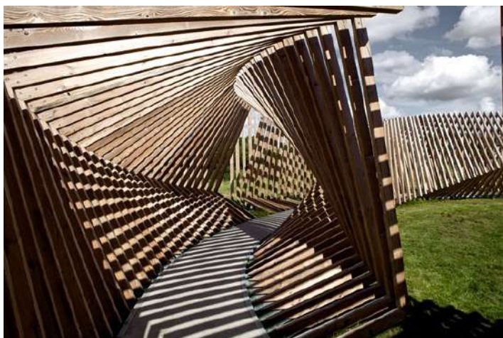
Ekko, Thilo Frannk, 2012. Recorrido de 20m x altura de 3m. 400 tablas en forma radial. Ekko Thilo Frank, la percepción dinámica del espacio, en experimenta.es
