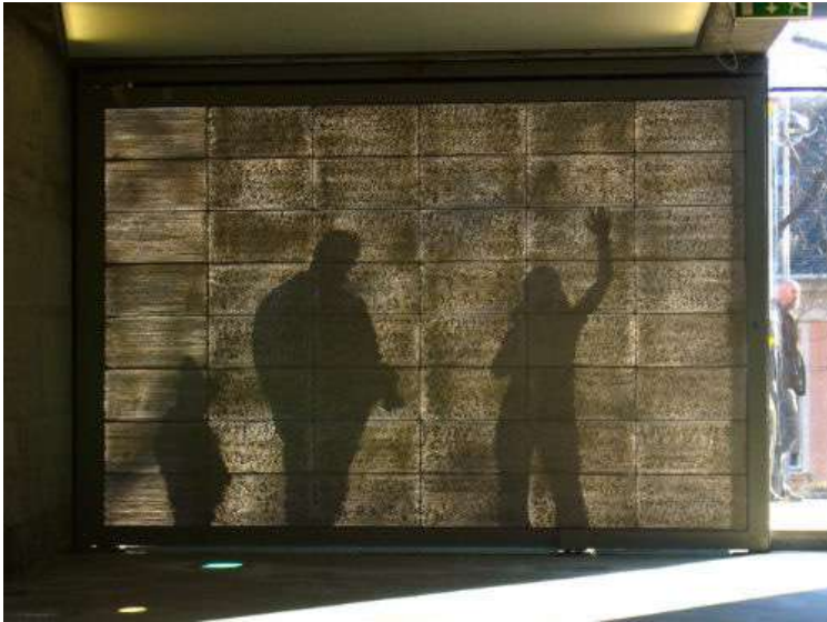
Concreto translúcido Litracon http://www.codeen.es/materiales/
