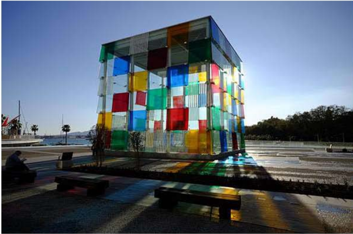
Centro Pompidou Málaga "El Cubo". Páneles de cemento traslúcido; Italcementi, i-ligth. Foto: Experimenta.es
