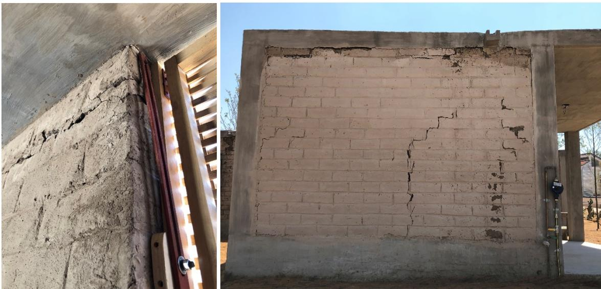
**Figura 12.** Incompatibilidad de materiales por combinación de sistemas constructivos, concreto y adobe. Fuente: Archivo propio de la autora. 2019
