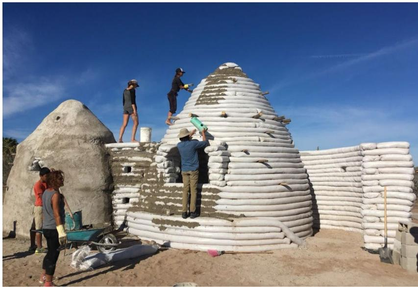
*Figura 17.* Izquierda, técnica constructiva de Superadobe, implementada por el arquitecto Nader Khalili, para poblar la luna y el planeta Marte. Fuente: [www.ranchouha.mx/en/event/superadobe-nov2017/](http://www.ranchouha.mx/en/event/superadobe-nov2017/).
