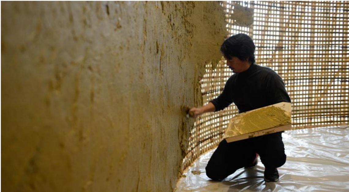
**Figura 26.** Kusumi Naoki aplicando el recubrimiento arakabe sobre entramado de bambú. Tomado de: kusuminaoki.com.
