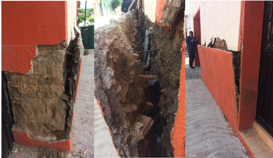
**Figura 13.** Desprendimiento de revoques de cemento y daños causados sobre la estructura de tierra. Fuente: Luis F. Guerrero, 2018.
