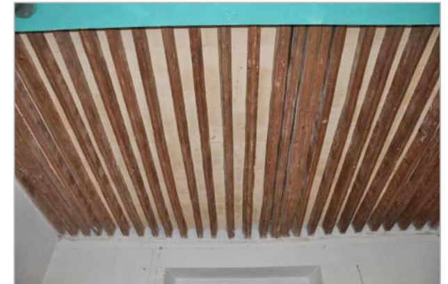
Entrepiso/losa a base de vigas de madera Fotografía propia tomada en septiembre 2017
