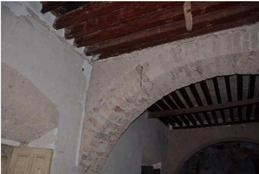
Ilustración 57 Entrepiso de vigas de madera y detalle del mismo, presente en el caso de estudio. Fuente: fotografía y elaboración propia.
