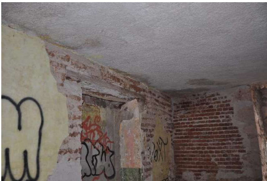
Ilustración 67 Imagen y detalle de losa de concreto armado, presente en el caso de estudio. Fuente: fotografía y elaboración propia.
