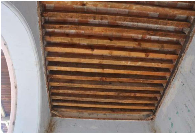
Ilustración 64 Losa a base de vigas de madera y detalle de la misma, presente en el caso de estudio. Fuente: fotografía y elaboración propia.
