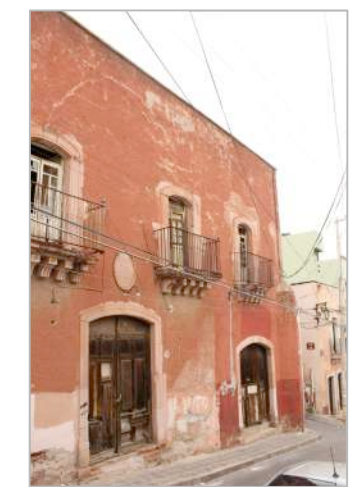
Fachada Sureste vista 2 Fotografía propia tomada en septiembre 2017
