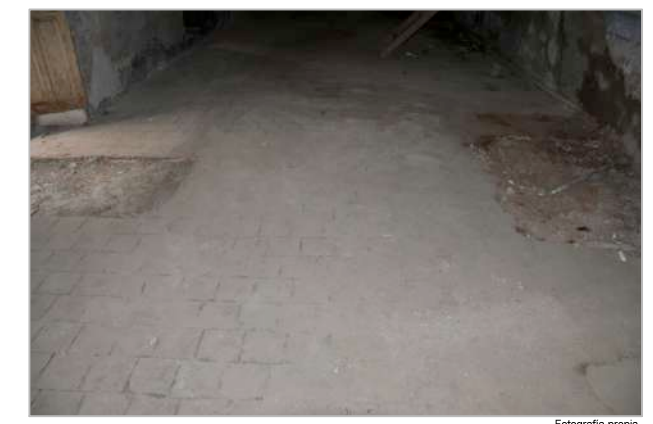
Piso de lajas de piedra
