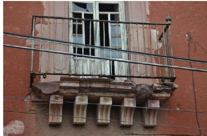
Ilustración 77 Deterioros en elementos ornamentales presentes en el caso de estudio. Fuente: fotografía propia.
