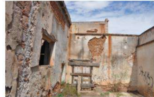
P4_APUNTALAMIENTO DE MUROS
