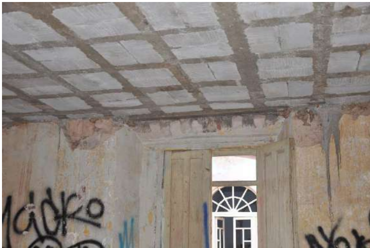
Ilustración 66 Imagen y detalle de losa con casetón aligerado, presente en el caso de estudio. Fuente: fotografía y elaboración propia.
