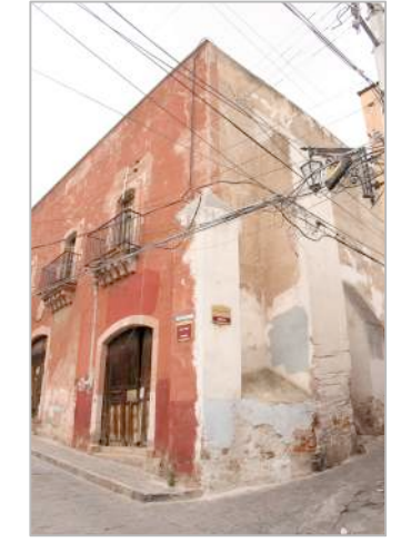
Fachada Sureste vista 1 Fotografía propia tomada en septiembre 2017
