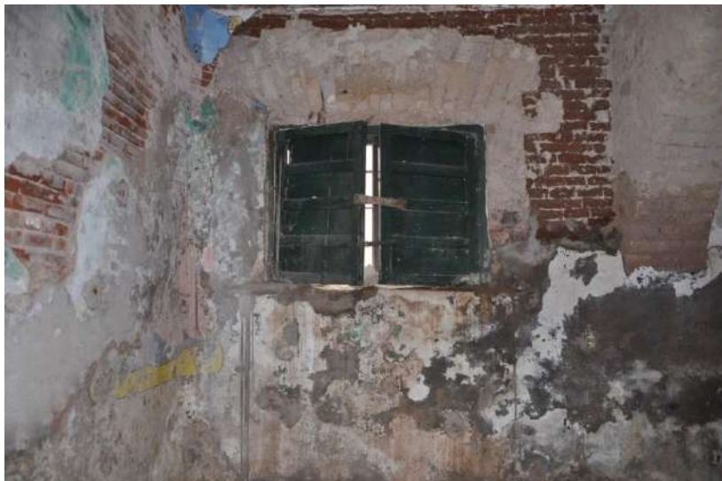
Ilustración 60 Muro de mampostería y detalle del mismo presente en el caso de estudio. Fuente: fotografía y elaboración propia.
