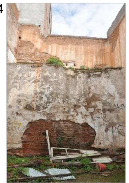
Muro de tabique rojo
