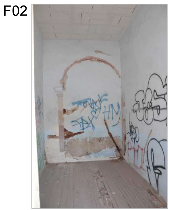
Acceso tapiado en pasillo supuesto Planta Alta Fuente: Fotografía propia tomada en agosto 2017
