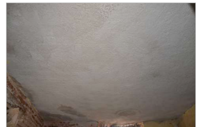
Losa de concreto armado Fotografía propia tomada en septiembre 2017
