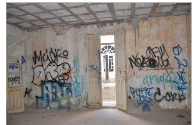
Losa de concreto armado aligerada con block de cemento Fotografía propia tomada en septiembre 2017
