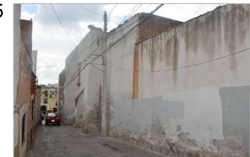
Fachada Noreste vista 1 Fotografía propia tomada en septiembre 2017
