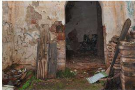
P1_LIMPIEZA GENERAL DE INTERIORES
