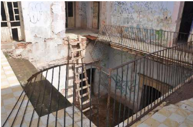
Ilustración 93 Pasillo de concreto armado que presenta riesgo estructural en la Casa del Cobre. Fuente: fotografía propia.
