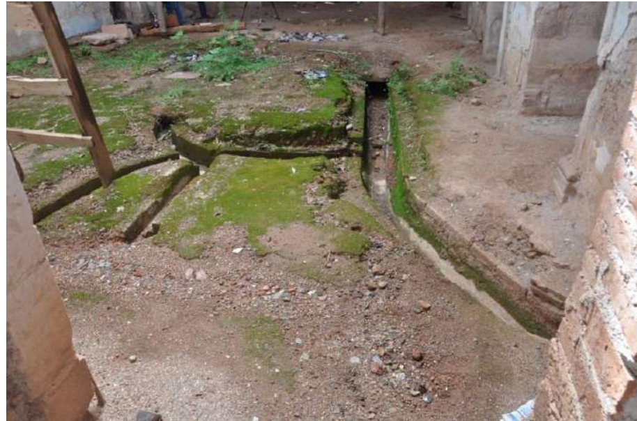
Ilustración 56 Terreno del caso de estudio. Fuente: fotografía propia.
