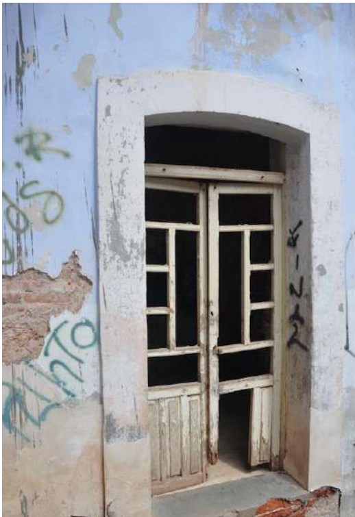
Ilustración 78 Deterioros en puertas de madera presentes en el caso de estudio. Fuente: fotografía propia.
