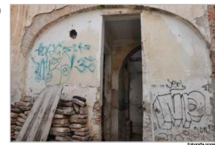
Vano tapiado con tabique
