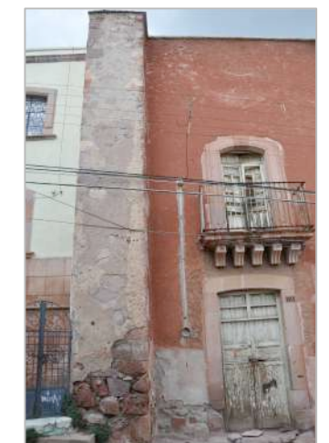
Fachada Sureste vista 3 Fotografía propia tomada en septiembre 2017
