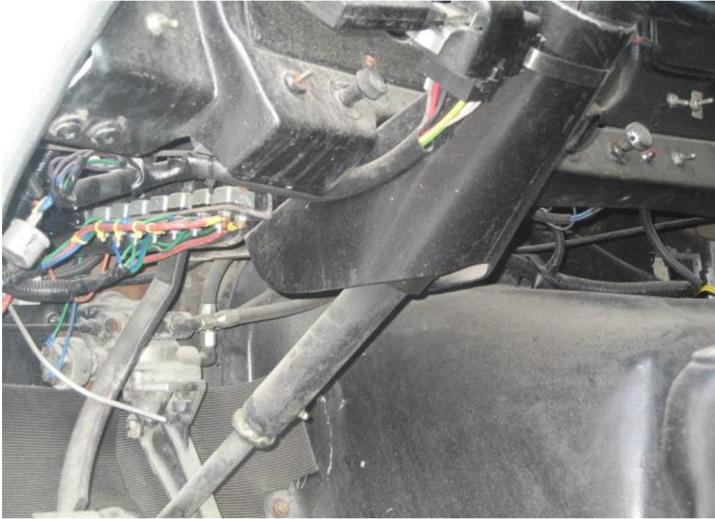
ACABADO DEL SISTEMA ELECTRICO
