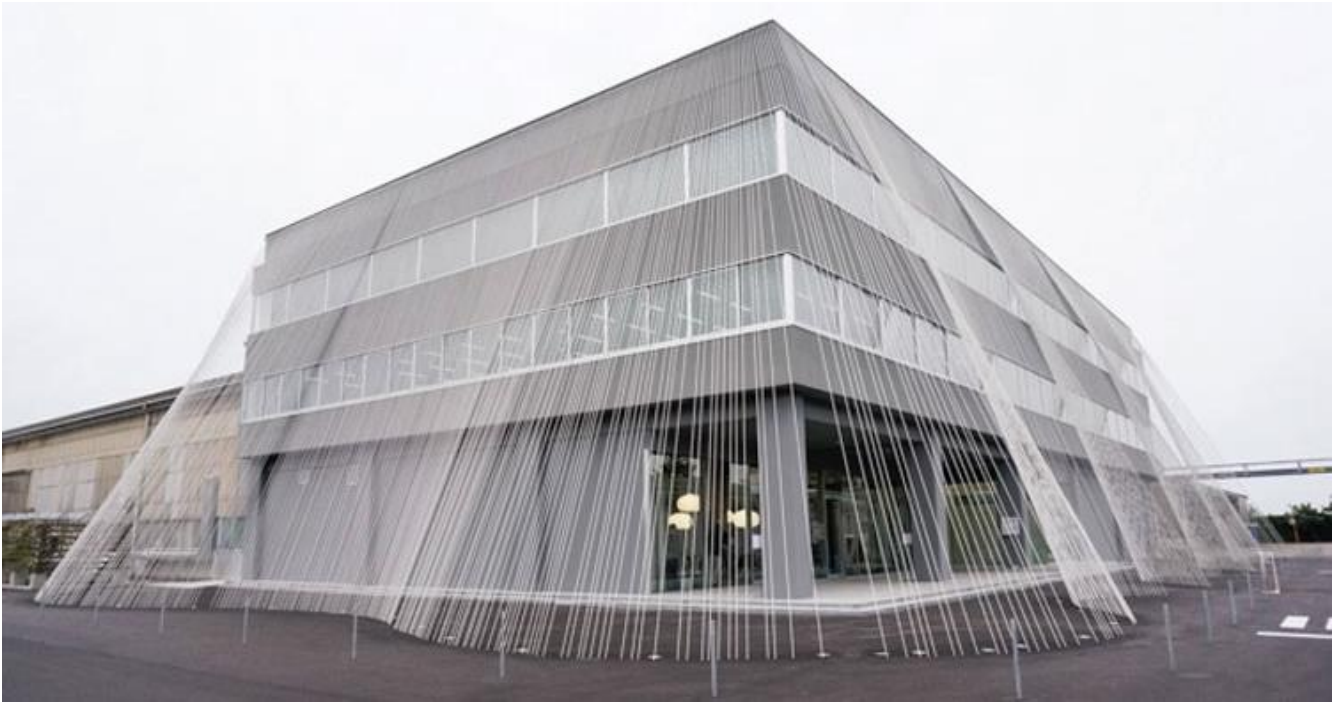
Figura 1. CABKOMA Strand Rod. Sistema antisísmico basado en fibras de carbono.
