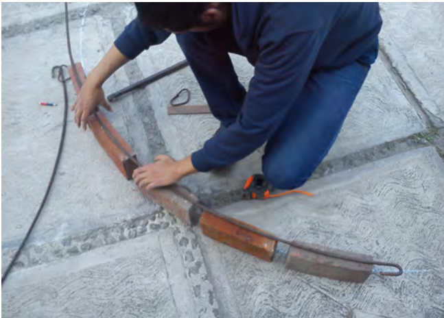
FIG_27 [izq] Trazo en pisoescala 1:1 [der] Armado de dovelas en molde.
