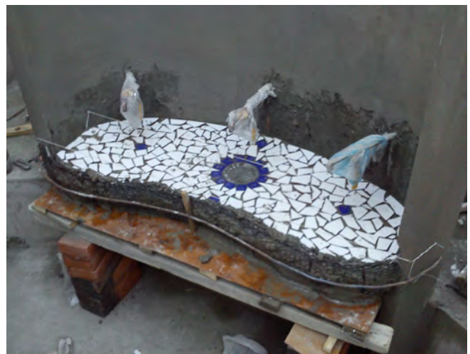
FIG 24 [izq] Armado de lavabos para niños [der] Colocación de acabado en lavabos.
