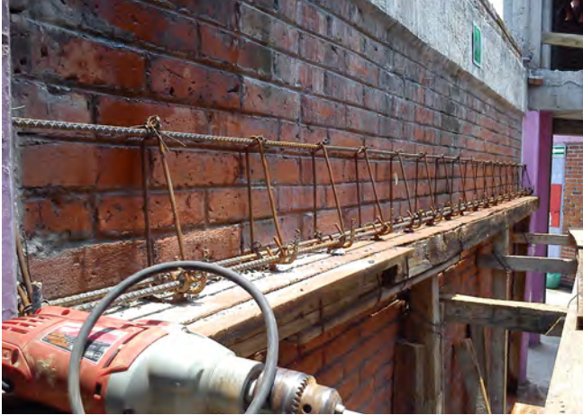
FIG_38 Armado y refuerzos de acero en cadenas de arranque en muros.
