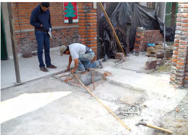
FIG_16 [izq] Trazo de trabe de basamento [der] Armado de trabe de basamento.
