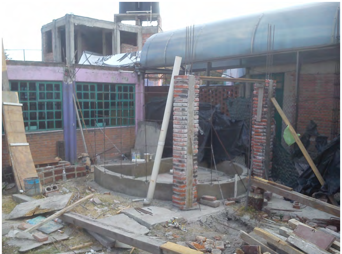
FIG_20 Cadena de basamento con varillas guía para muros de ferrocemento.
