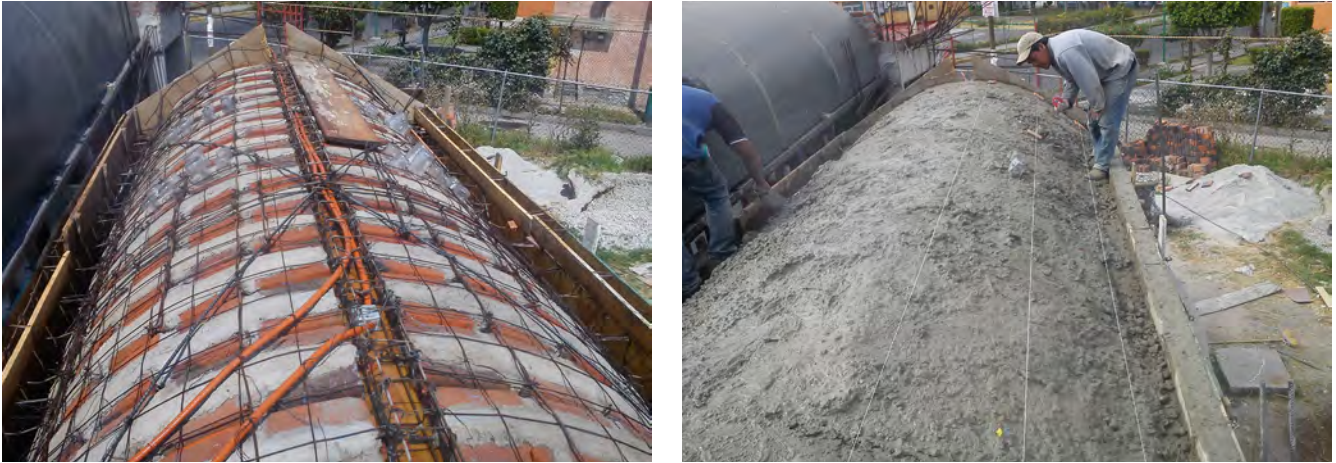
FIG_30 [izq] Montaje de dovelas y colocación de instalación eléctrica [der] Colado de traves y capa de compresión sobre dovelas.
