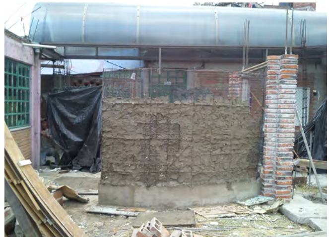
FIG 23 [izq] Enjarre de concreto sobre metal desplegado [der] Paredes de ferrocemento.
