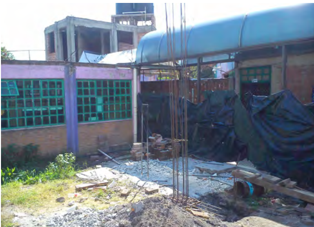
FIG_15 [izq] Sitio de las obras [der] Molde para dovelas.
