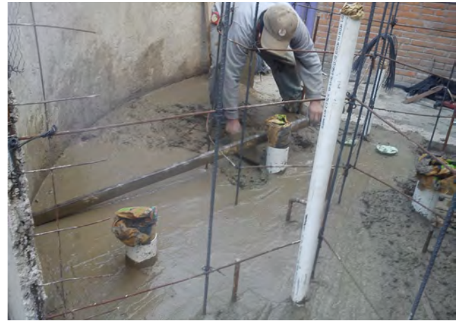
FIG_17 [izq] Instalación sanitaria [der] Colado de firme de cocconcreto.
