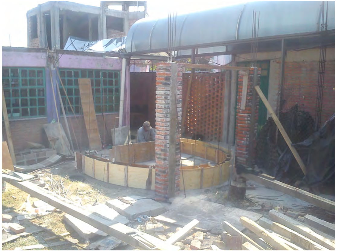
FIG_19 Colocación de cimbra flexible de hojas de triplay.
