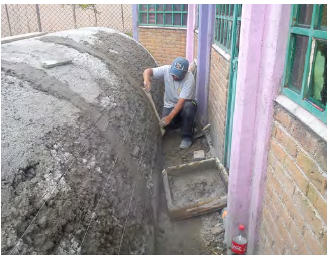
FIG_39 Rectificación del molde para dovelas.
