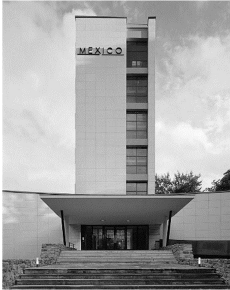
Gráfico 21: Acceso principal a La casa de México Archdaily2019
