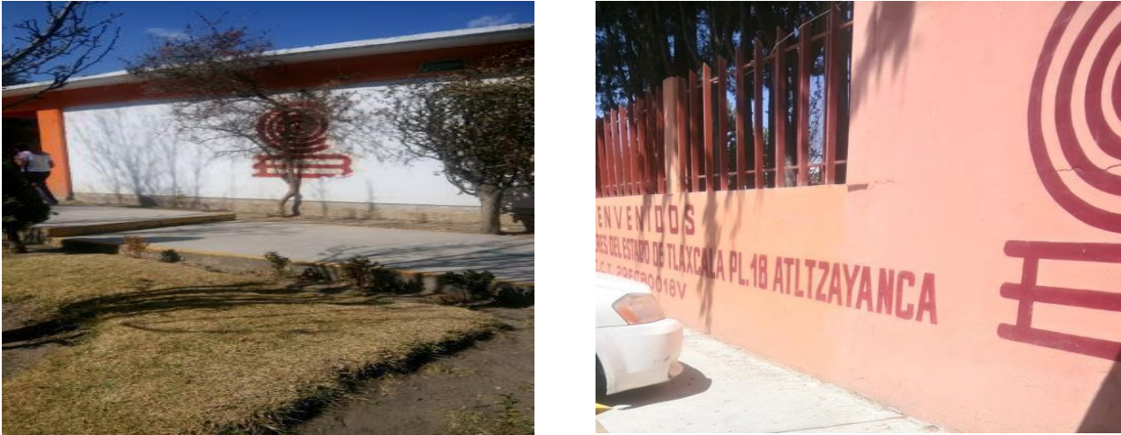
Figura 2. Entrada e interior de COBAT 18 Atltzayanca Fuente Archivo Propio.
