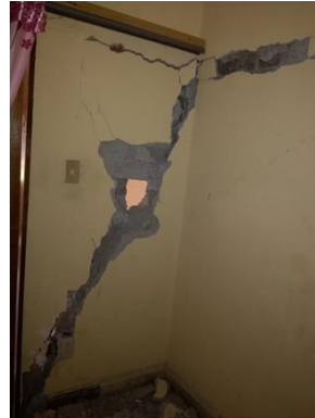
VISTA DE MURO EN COCINA
