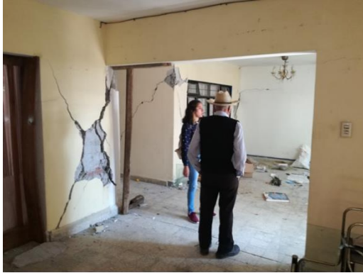
VISTA DE INTERIOR DE LA SALA
