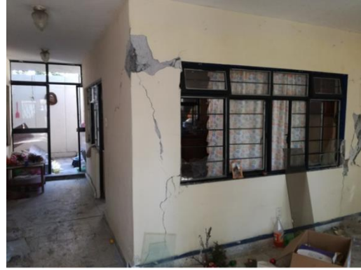
VISTA DESDE EL ACCESO
