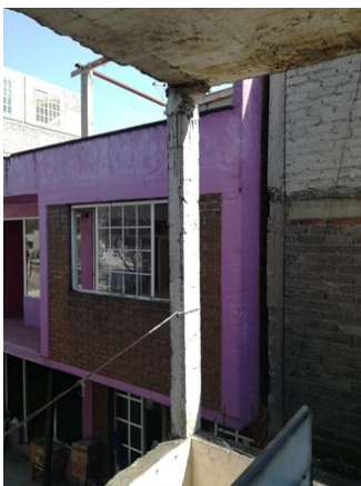
VISTA DE SOPOTE DE LOSA
