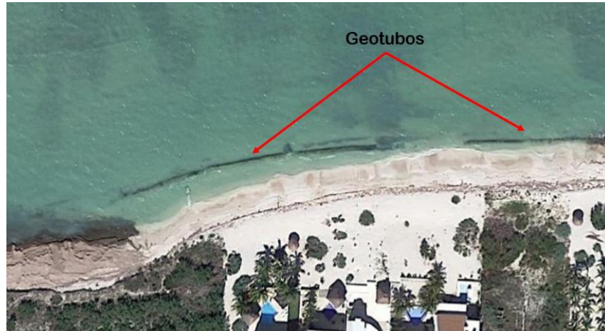
Figura 6. Geotextiles presentes en la costa de Yucatán.
