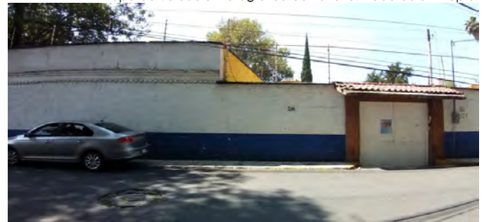
4.- Acceso de vehículos, Fotografía 2019. Foto Propia.
