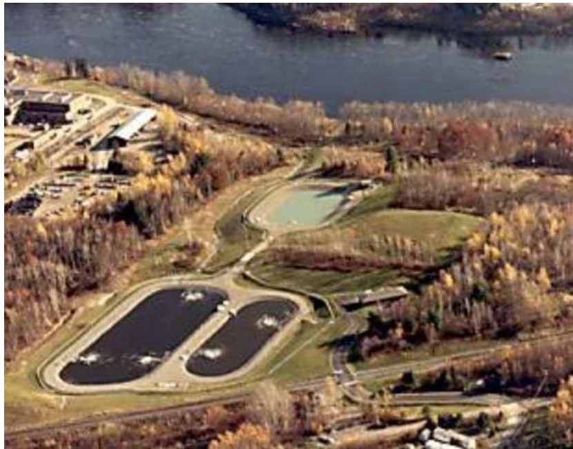
Figura 5-1. Vista aérea del sistema de lagunas aireadas del Distrito Sanitario de Veazie, Maine, USA (DEP, 2003).
