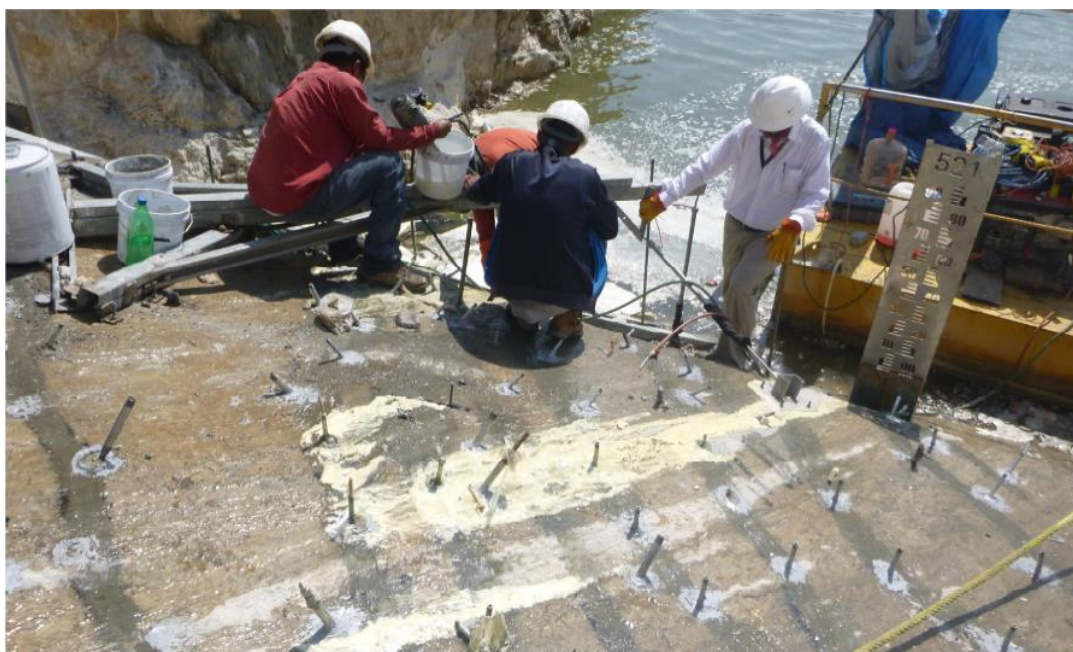
Figura 53. Reparación de fracturas localizadas en la losa del plinto, vista desde la berma +522, (CFE, agosto 2015).
