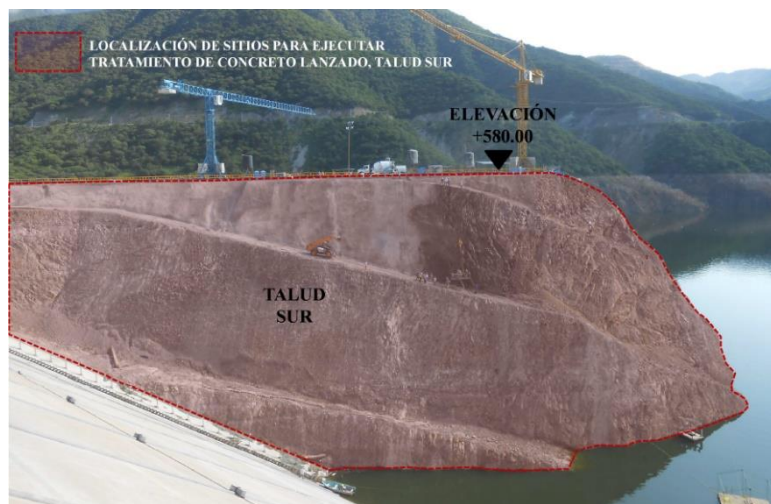
Figura 47. Proyección de sitios donde se ejecutaron tratamientos de concreto lanzado, vista lateral del Talud Sur del espolón de roca, (CFE, agosto de 2014).
