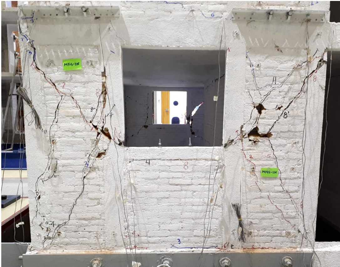
Fig. 3.56. Estado final de daño en muros esbeltos de primer nivel en fachada sur (eje C)
