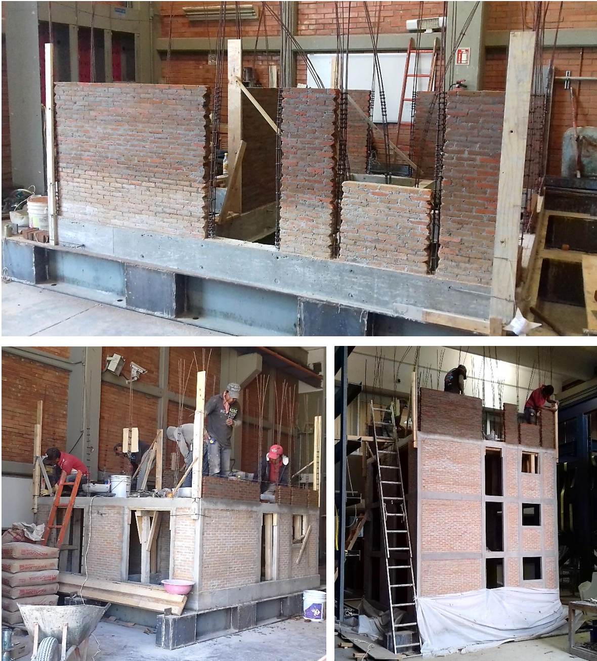
Figura 2.37. Construcción de muros confinados
