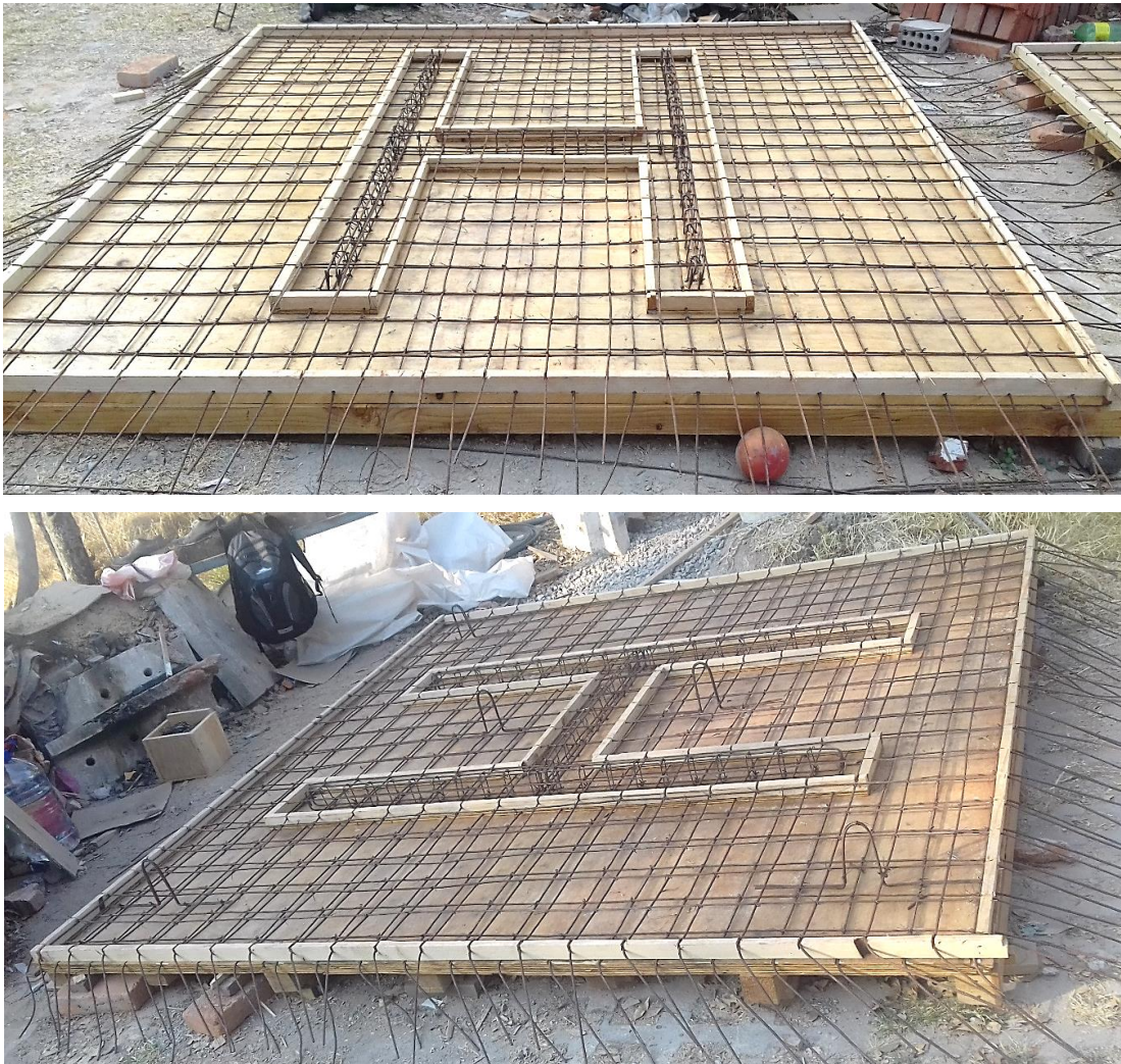
Figura 2.38. Construcción de losas prefabricadas de concreto
