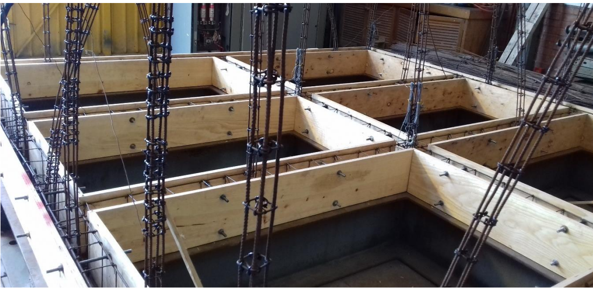
Figura 2.32. Cimbra en dala de cimentación
