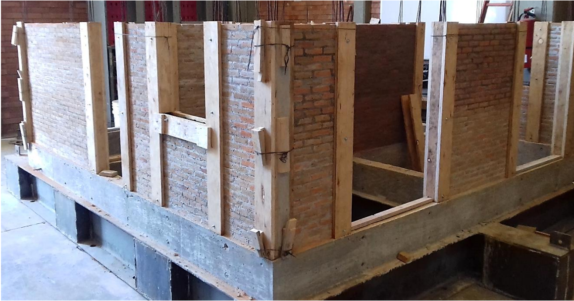
Figura 2.35. Cimbra en castillos de primer nivel
