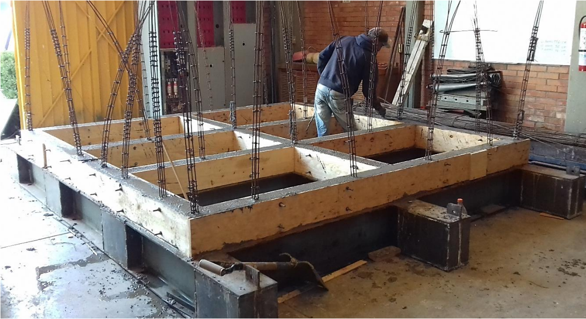
Figura 2.33. Colado de dala de cimentación
