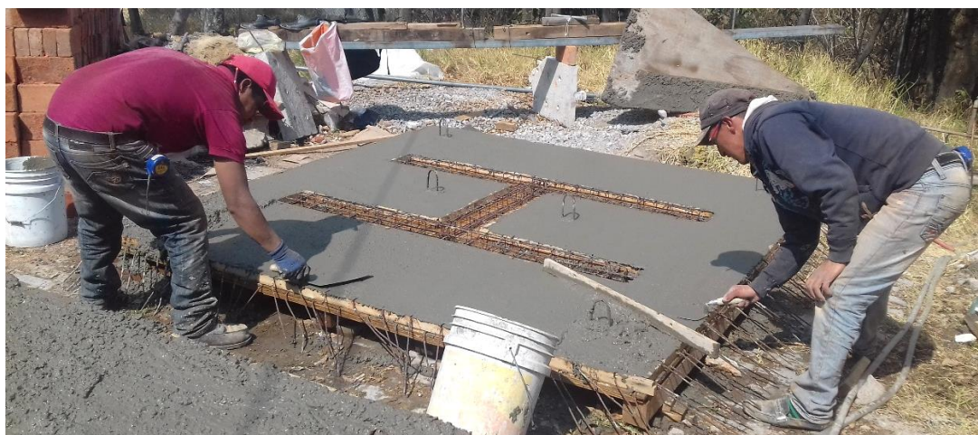
Figura 2.39. Colado de losas prefabricadas
