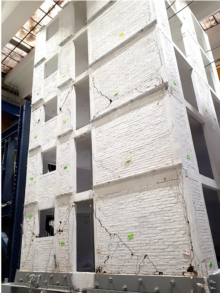
Fig. 3.53. Estado final de daño en la fachada sur (eje C)
