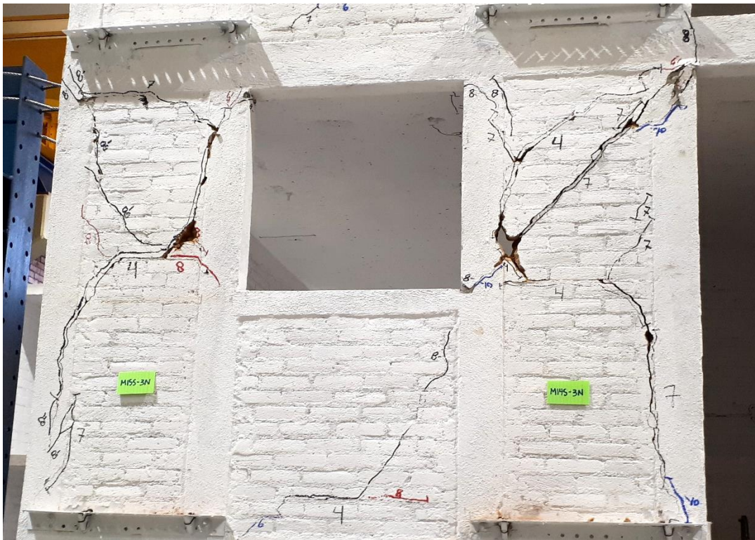
Fig. 3.57. Estado final de daño en muros esbeltos de tercer nivel en fachada sur (eje C)
