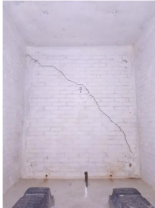
Muro M17 – segundo nivel
