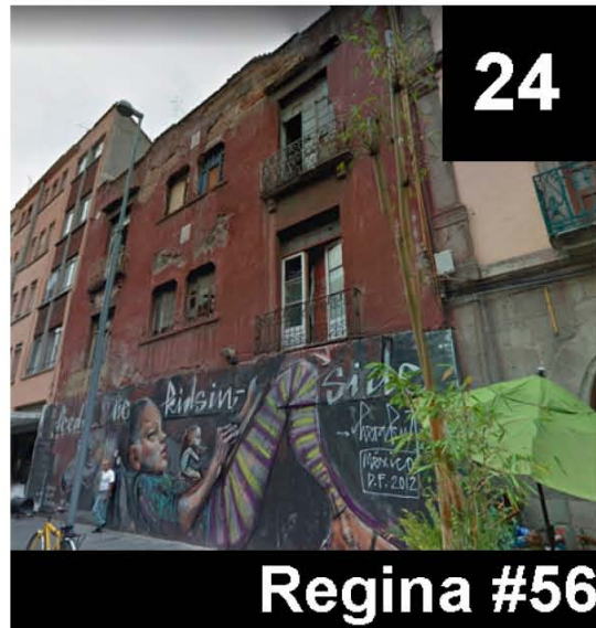
Fotografías tomadas en sitio.
