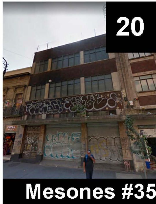
Fotografías tomadas en sitio.
