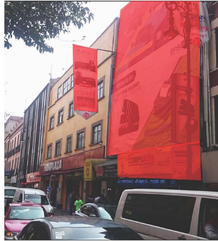
En rojo se señala la publicidad que cubre la fachada del edificio. Ocultando elementos arquitectónicos como ventanas o molduras
