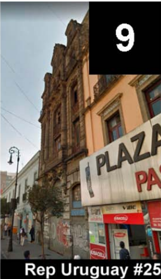
Fotografías tomadas en sitio.
