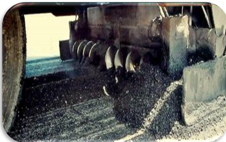
Ilustración 34: Rodillos sin fin, recuperando el reciclado. (MMG, 2019)
