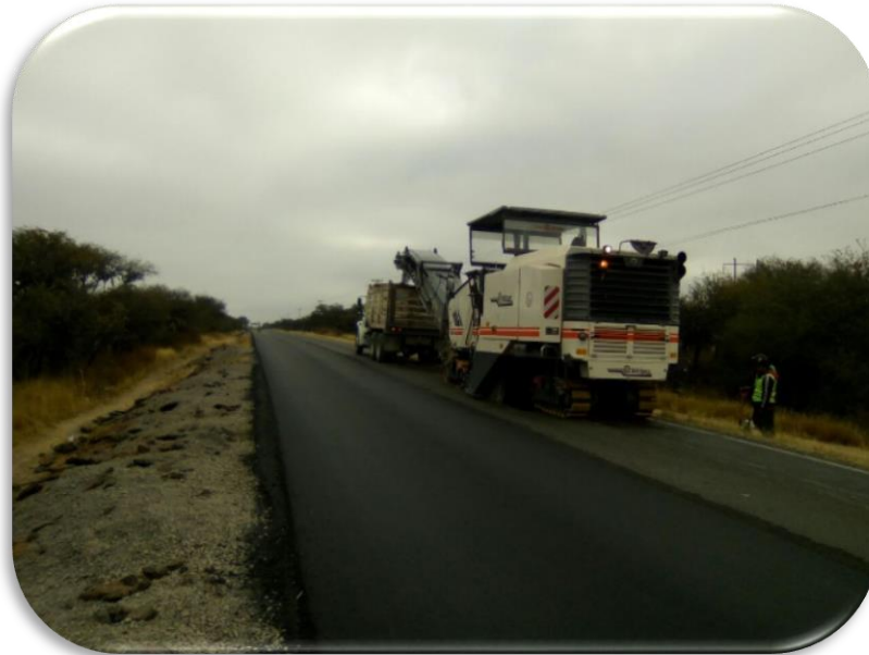
Ilustración 22: Fresado de sección de bacheo superficial (MMG, 2019)
