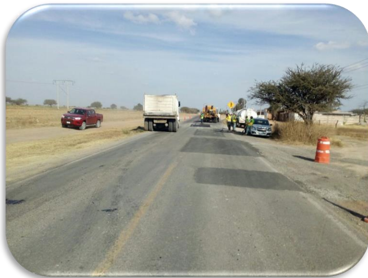
Ilustración 24: Bacheo Superficial (MMG, 2019)
