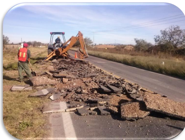
Ilustración 25: Demolición de la carpeta dañada. (MMG, 2019)
