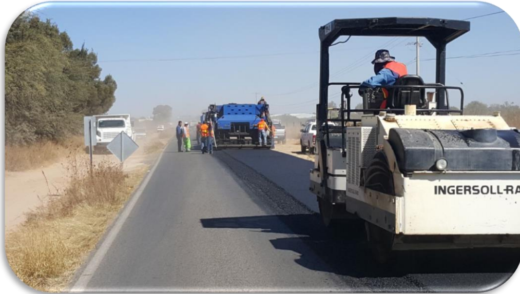
Ilustración 38: Proceso de compactación. (MMG, 2019)
