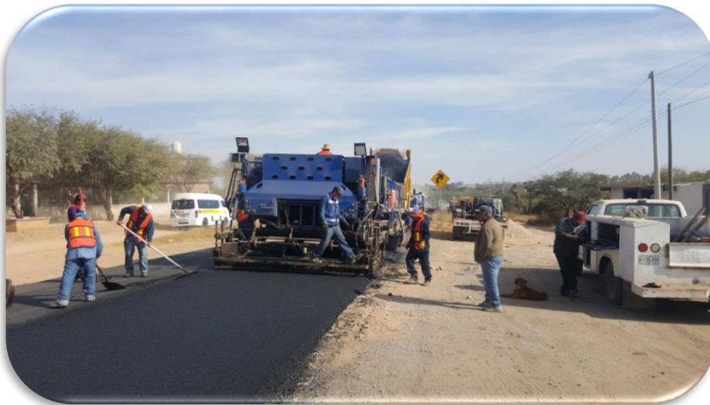
Ilustración 36: Carpeta distribuida en ancho y espesor final, con el proceso de reciclado y carpeta nueva. (MMG, 2019)
