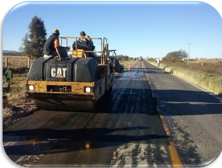
Ilustración 27: Colocación y compactación de la carpeta nueva. (MMG, 2019)
