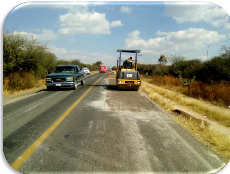
Ilustración 23: Compactación de la caja del bacheo superficial. (MMG, 2019)
