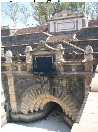
Imagen 11. Entrada al túnel de Tequixquiac, en Zumpango
