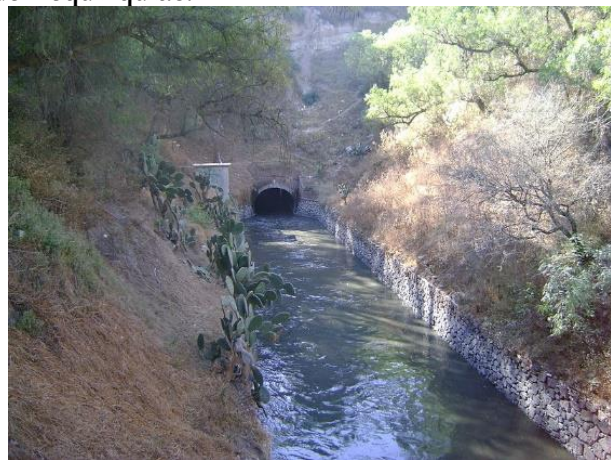
Imagen 12. Salida del primer túnel de Tequixquiac y su desembocadura al río el Salado
