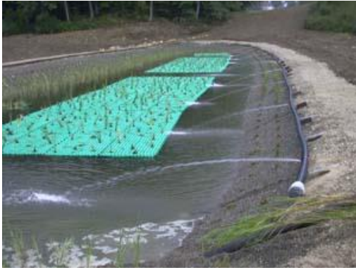
Imagen 55 y 56. Vista del proceso de instalacion de las islas flotantes
