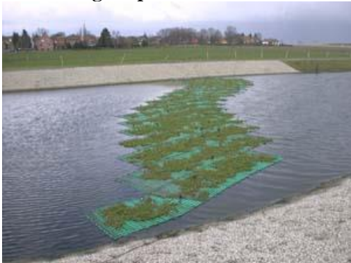
Imagen 53 y 54. Vista del proceso de establecimiento de las islas flotantes
