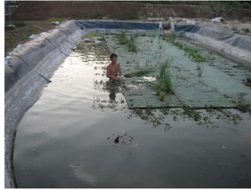
Imagen 55 y 56. Vista del proceso de instalacion de las islas flotantes
