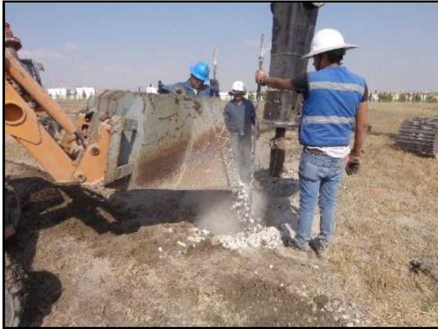
Figura 29.- Vertido de la grava en la perforación
