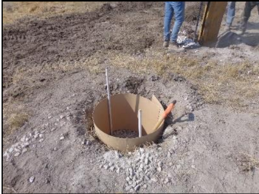
Figura 31.-Apisonamiento para general fuste del Geopier
