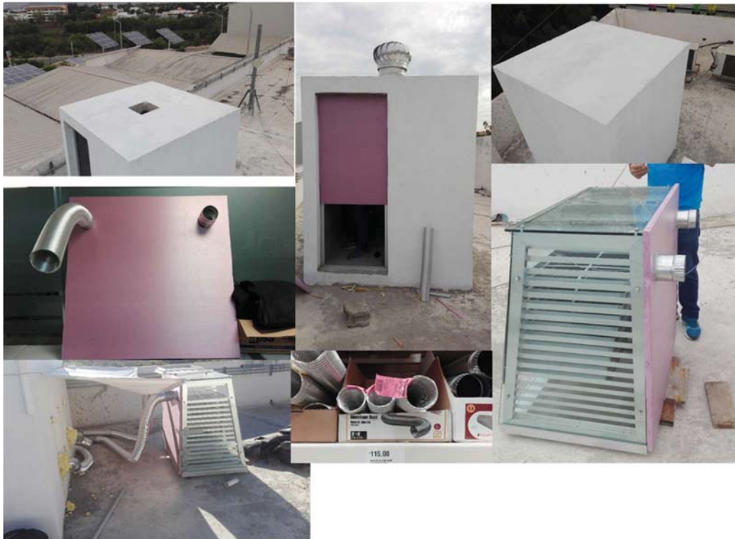
Fig. 106. Construcción proceso experimental. Fuente: Propia.
