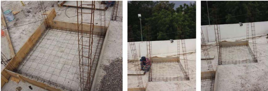
Fig. 94. Proceso inicial de construcción módulos. Fuente: Propia
