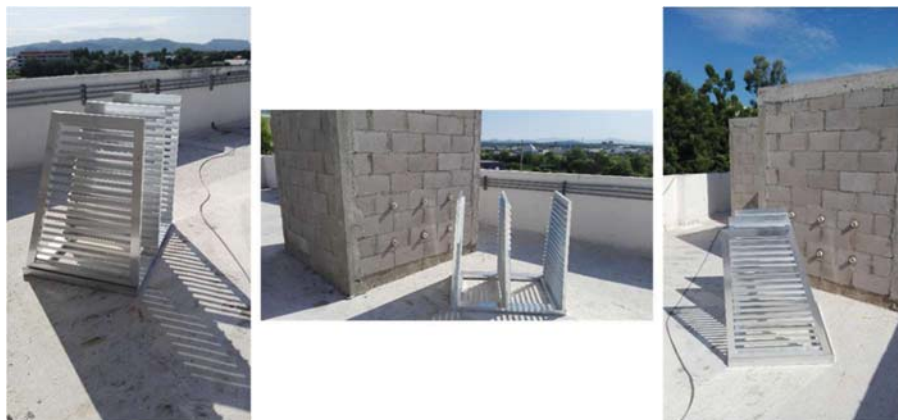
Fig. 100. Instalación del invernadero contenedor de la zeolita. Fuente: Propia
