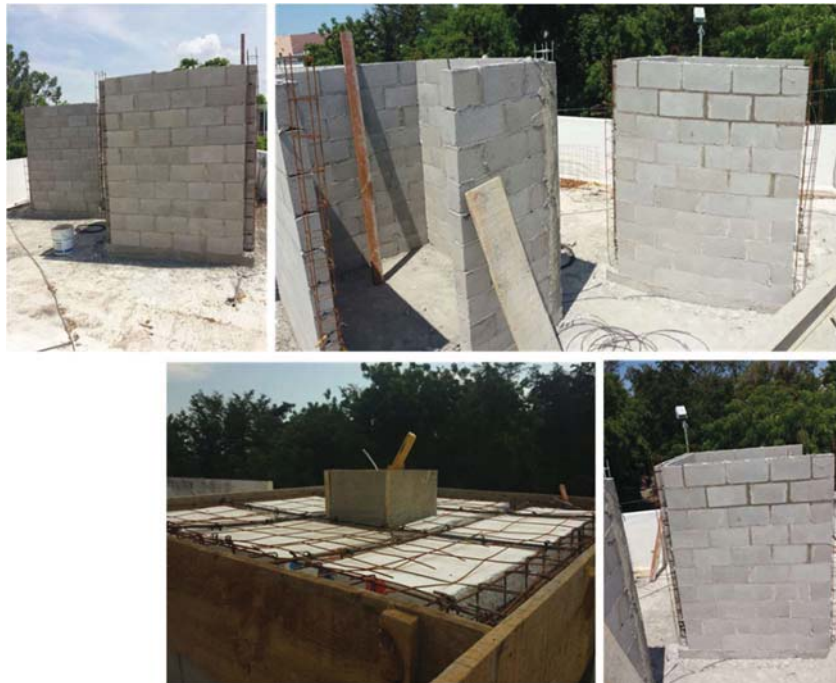
Fig. 96. Levantamiento de muros, y vaciado de losa módulos de experimentación. Fuente: Propia
