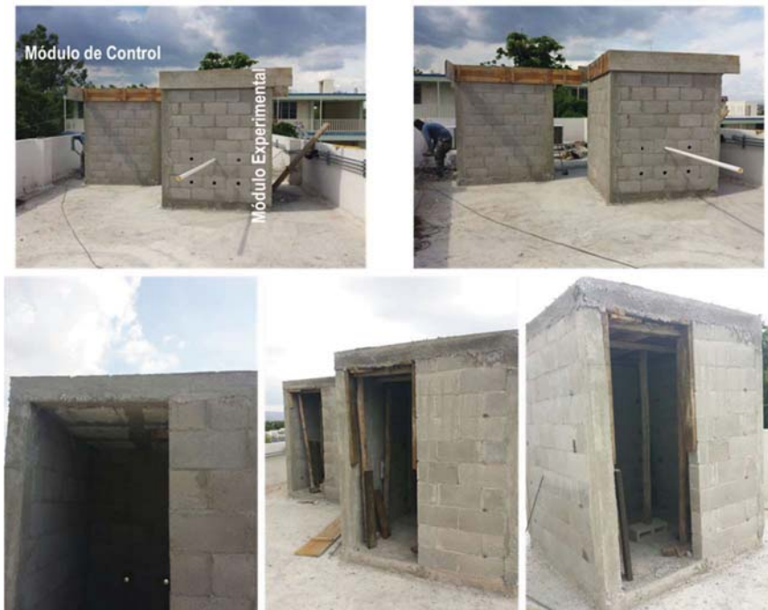
Fig. 98. Trabajos finales, módulos de experimentación. Fuente: Propia
