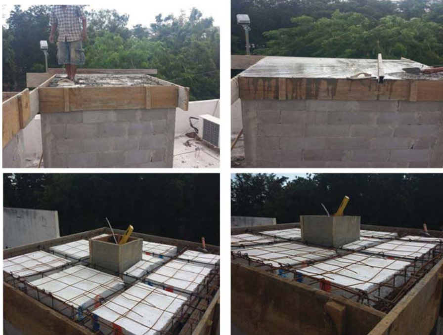
Fig. 97. Vaciado de losa, módulos de experimentación. Fuente: Propia
