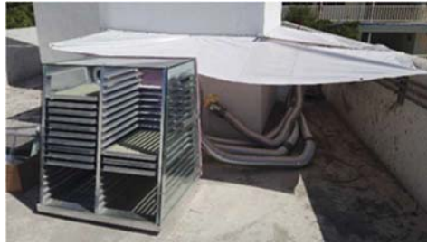
Fig. 109. Construcción proceso experimental, conexión con tubos de aluminio flexible. Fuente: Propia.
