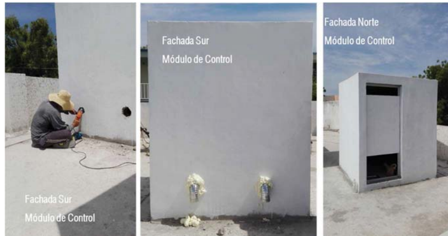
Fig. 112. Montaje módulo de control. Fuente: Propia.
