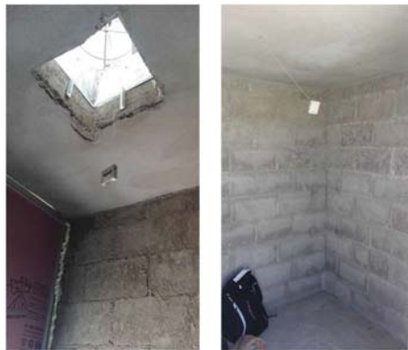
Fig. 110. Instalación de sensores en los módulos de estudio. Fuente: Propia
