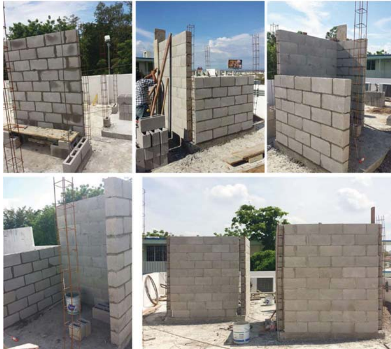
Fig. 95. Levantamiento de muros, módulos de experimentación. Fuente: Propia
