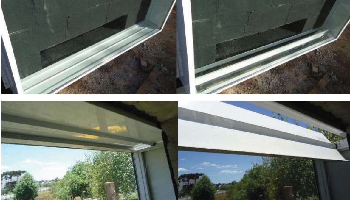
Fig. 12. Proceso constructivo: vidrio doble en el diseño del muro Trombe. Fuente: Suzuki et al (2012).
