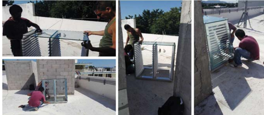
Fig. 101. Instalación del invernadero contenedor de la zeolita. Fuente: Propia.
