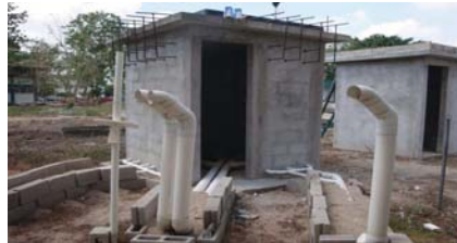
Fig. 18. Construcción del Sistema SAI. Fuente: López (2010).
