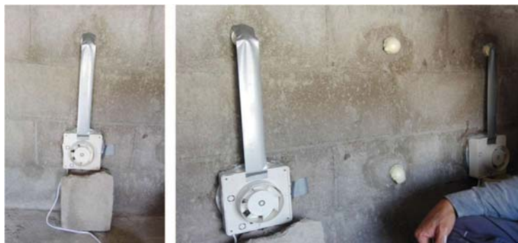
Fig. 113. Instalación de extractores los módulos de experimentación. Fuente: Propia
