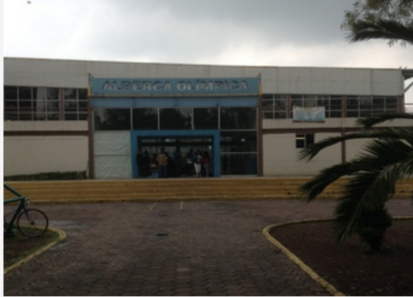
Imagen1. Fachada Norte o principal de la alberca Fotografía del autor tomada el 18 agosto 2017.
