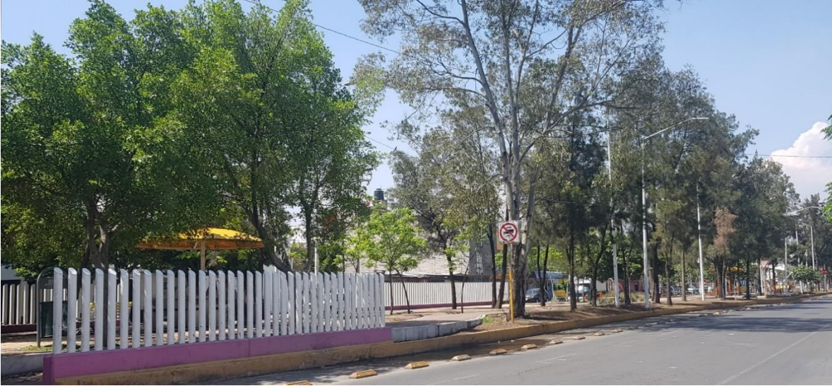
Ilustración 19: Detalle del cercado de protección en el espacio ubicado en la mediana de la avenida Nezahualcóyotl, colonia Tamaulipas.
