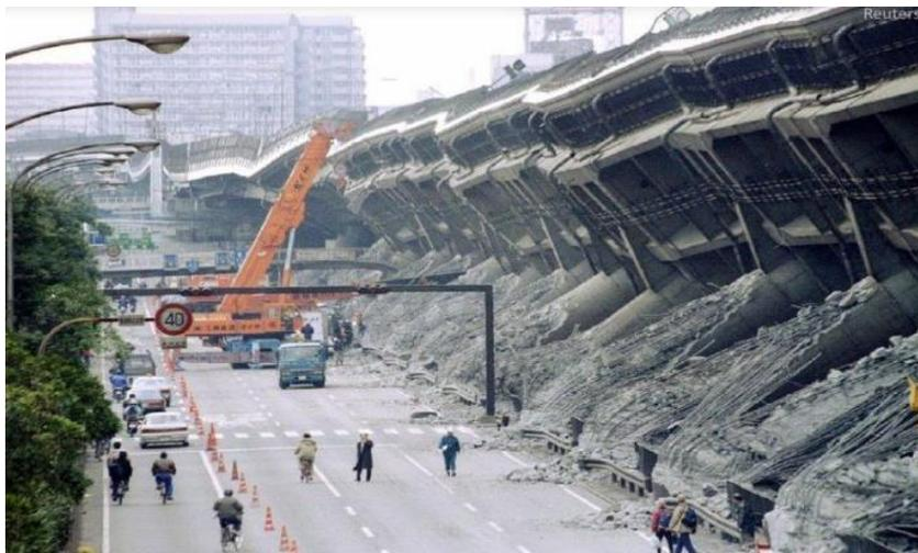
*Fig. 1.1 Colapso de la autopista elevada en el centro de Kobe, Sismo de Kobe (1995).*
