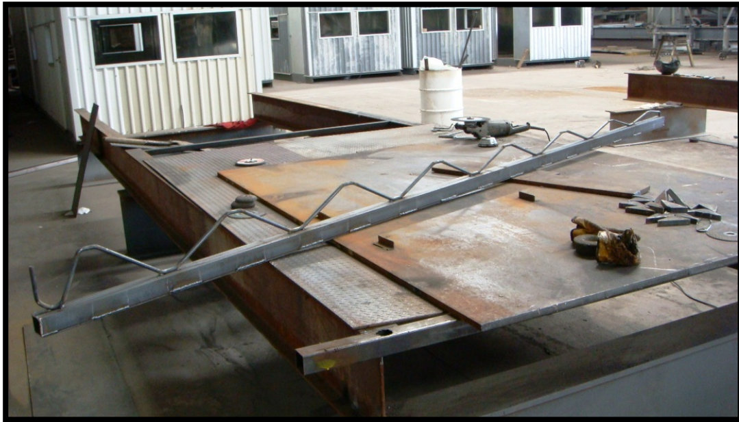
Construcción - Foto 11. Fabricación de largueros de techo ligeros a base de viga Vierendeel .
