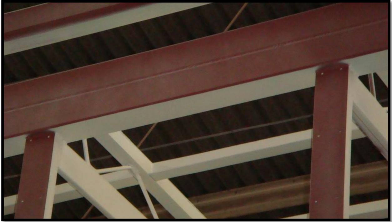
Construcción - Foto 7. Aplicación de primario (en rojo) y pintura de terminación.
