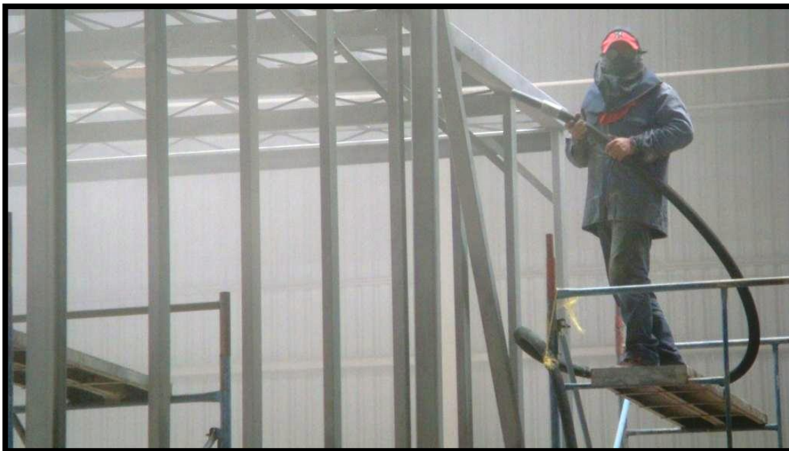
Construcción - Foto 6. Proceso de arenado o sanblasteo.
