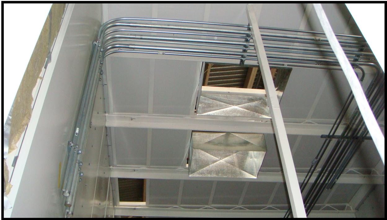
Construcción - Foto 10. Instalación eléctrica baja tensión.
