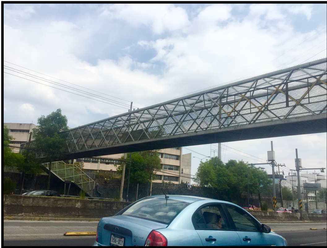
2° Diseño - Fig. 1. Estereoestructura en puente peatonal de gran claro sin necesidad de apoyo central, ubicado en la Avenida Insurgentes Sur de la CDMX a la altura de la Ciudad Universitaria. Dicha estructura está construida a base de PTR ligero de 3", Canal de 10" (idéntico a la plataforma base de nuestro contenedor) y losacero ®.
