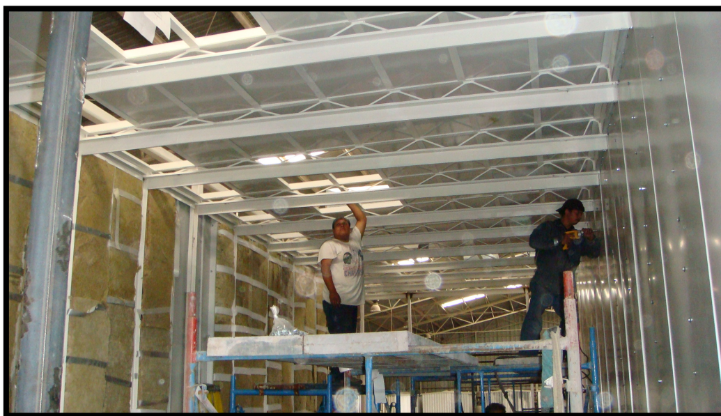
Construcción - Foto 12. Instalación de largueros de techo ligeros a base de viga Vierendeel . Nótese la instalación de charolas de lamina para configurar un plafón. Tanto muros como techo fueron aislados con lana mineral de roca.
