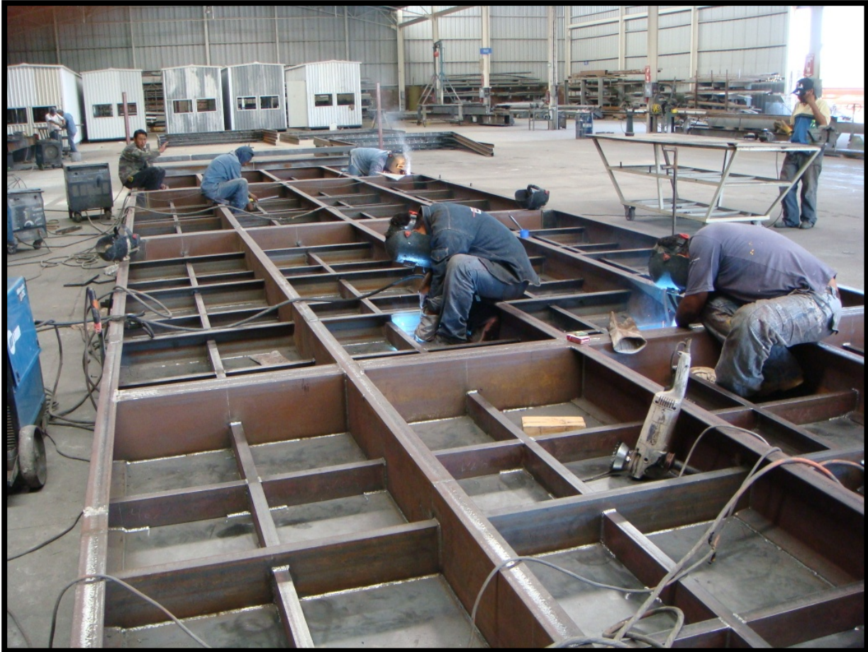
Construcción - Foto 1. Refuerzo de la plataforma base estructural según plano aprobado para fabricación.
