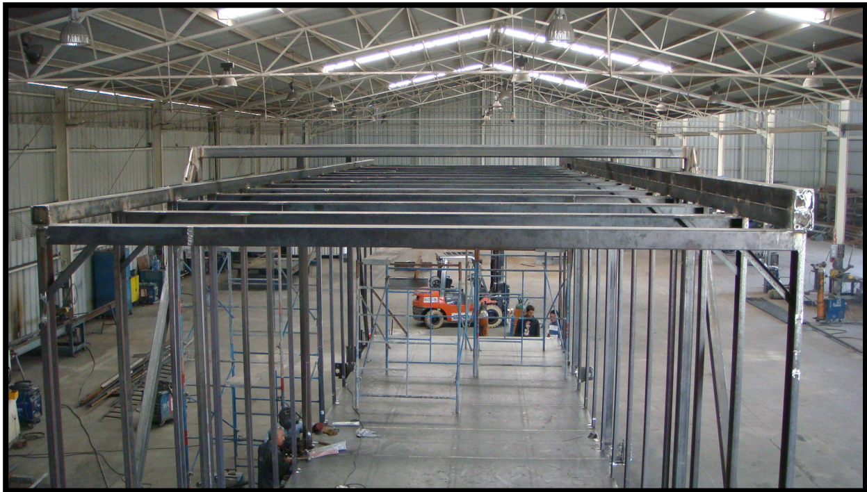
Construcción - Foto 3. Soldado de perfiles ligeros PTR de 4" para integración de muros y techo a los marcos rígidos. Nótese que de un lado tenemos dos perfiles y en el otro solo uno. Esto es para el cumplimiento de la especificación que ordena 2% de pendiente en el techo.
