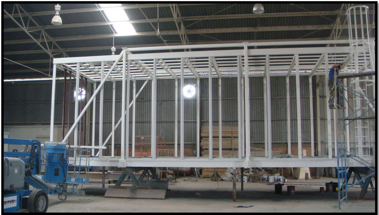
Construcción - Foto 8. Estructura muestra pintura de terminación.
