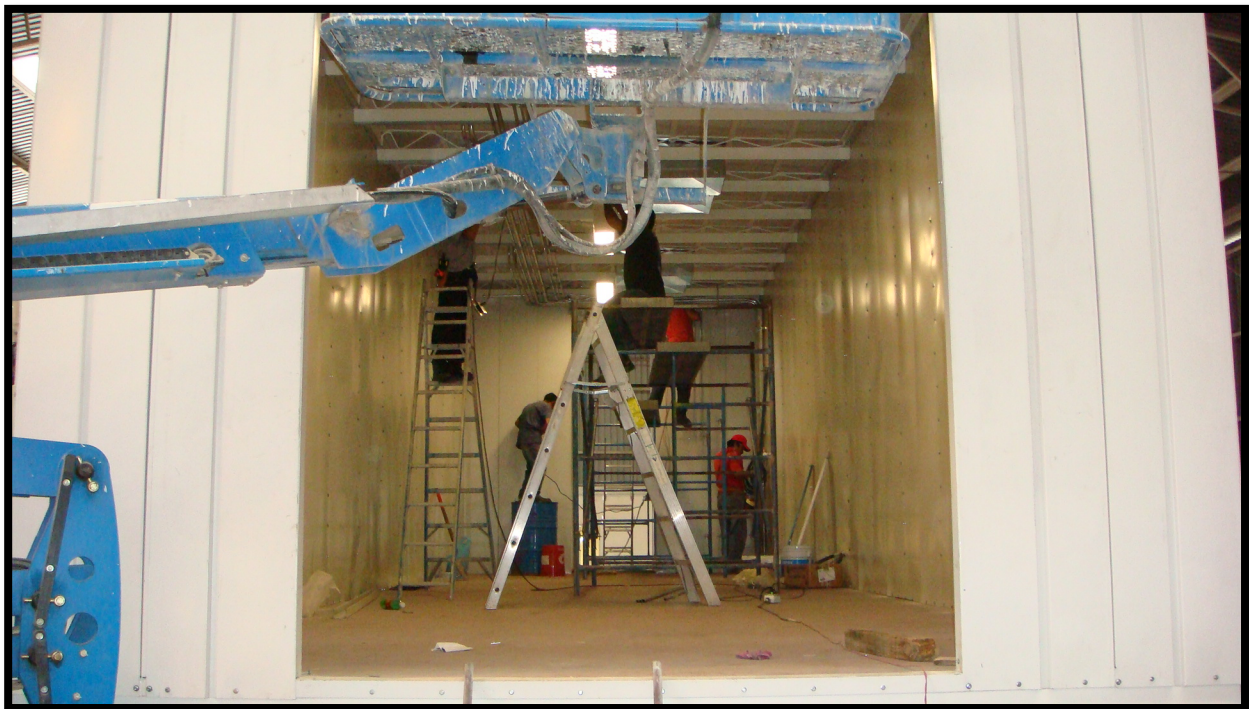
Construcción - Foto 11. Prueba de iluminación.
