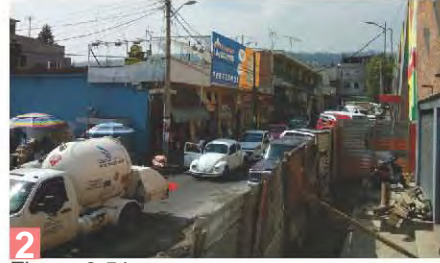
Figura 3.51. VISTA DESDE EL TERRENO
