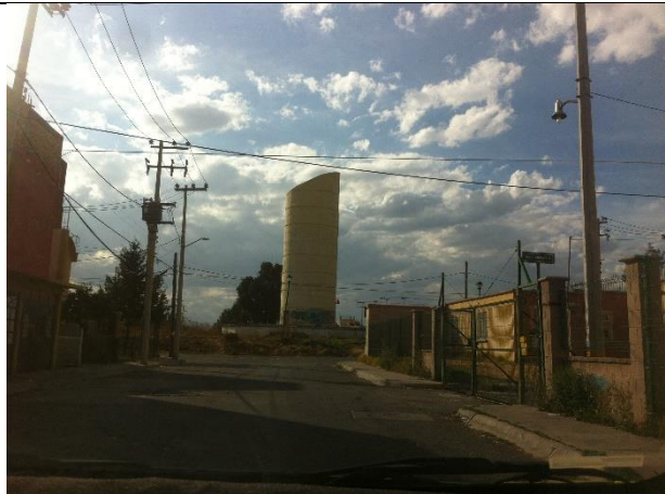
Tanque elevado "amarillo" 27 febrero 2019
