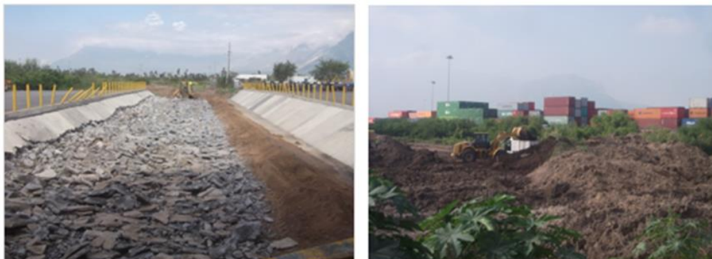
Fig. 2.5 Demolición y limpieza de terreno
