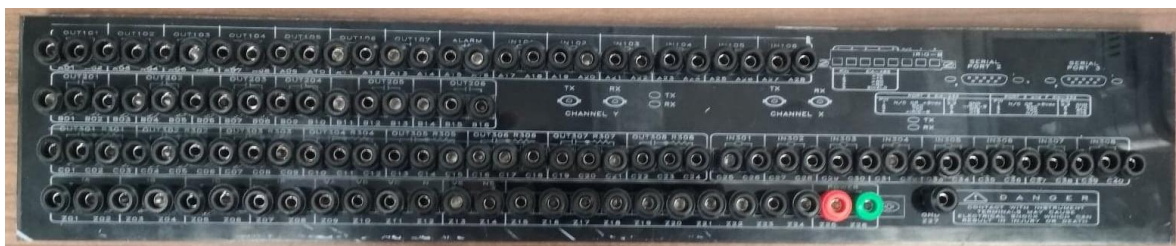
Figura 65. Montaje final de plugs en panel de policarbonato SEL-311L.
