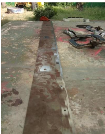
Figura 29. Orificios para el montaje de equipos y paneles.
