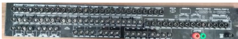
Figura 62. Montaje final de plugs en panel de policarbonato SEL-351s.
