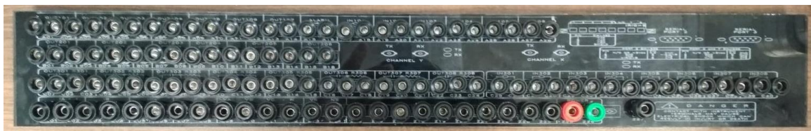
Figura 64. Montaje final de plugs en panel de policarbonato SEL-311L.
