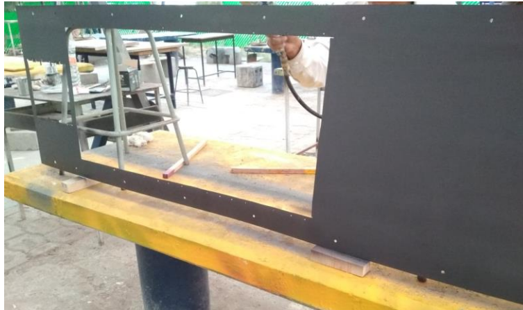
Figura 38. Proceso aplicación de PINTURA de relleno a caratula principal.
