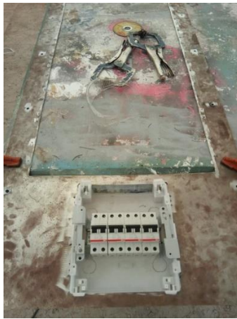
Figura 34. Corte y empotramiento correcto. Nota: En ella se muestra el empotramiento correcto del centro de carga al panel principal.
