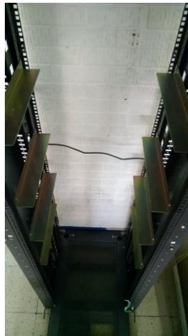
Figura 27. Representación de rieles montados en gabinete.
