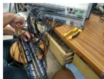
Figura 67. Proceso de cableado SEL-351s. Nota: En ella se muestra el proceso de cableado entre las terminales de entrada y salida, hasta los conectores montados sobre los paneles de policarbonato del equipo SEL-351s.
