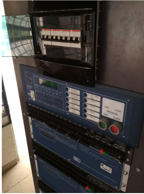
Figura 85. Presentación de centro de carga empotrado y fijado. Nota: En ella se muestra el resultado final del empotramiento y fijación a la caratula principal del centro de carga, contando ya con sus respectivos interruptores electromagnéticos.
