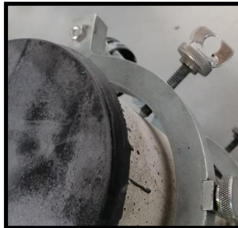
Figura 3.2.10. Fijar los anillos por los anillos de punta para evitar desplazamientos.
