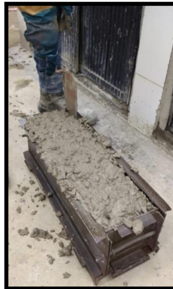
Figura 2.5.17. Introducir y sacar la cuchara de albañil rápidamente.
