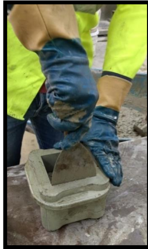
Figura 2.5.15. En moldes cúbicos se recomienda usar espátula.
