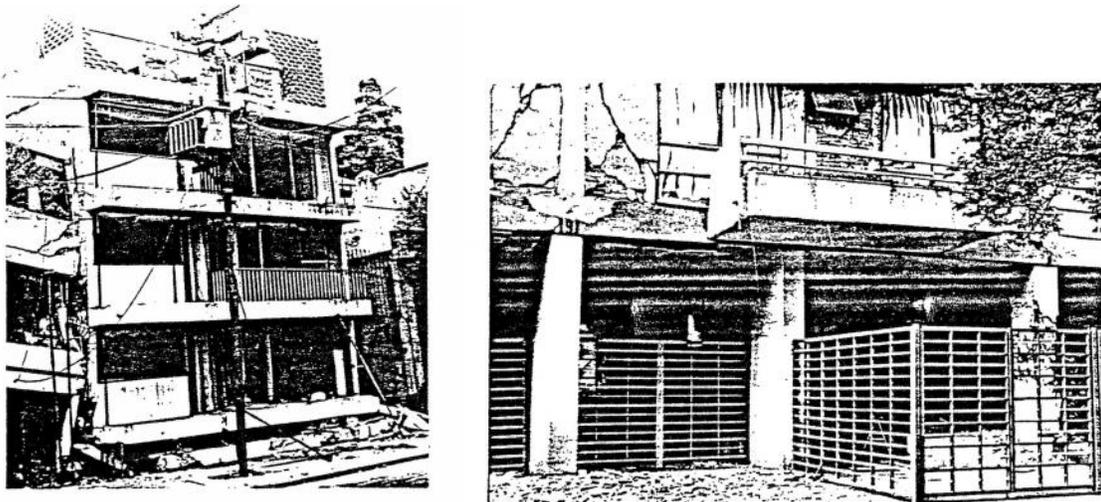
**Figura 1.1.** Estructura colapsada y estructura con daño originado en el sismo de 1985 por estructuración con *planta baja débil*.
