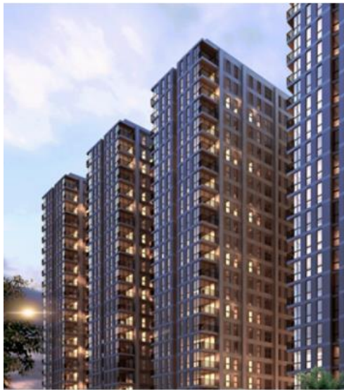
Vista exterior del edificio.
