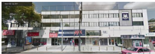
Calzada Tlalpan Constitución: planta baja comercial más cuatro niveles.
