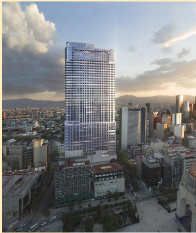
Vista exterior del edificio.
