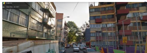
Cerro San Antonio Constitución: planta baja comercial más cuatro niveles.
