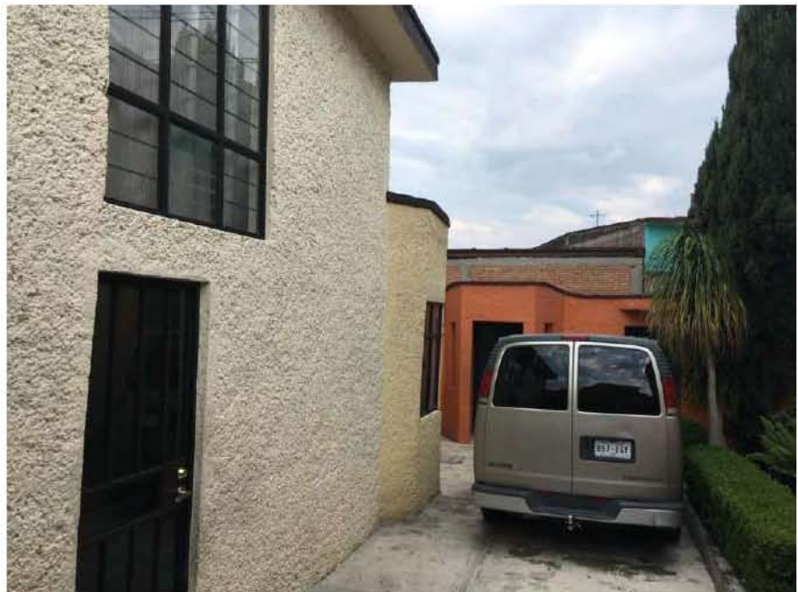
Gráfico 3.6.16 Vista del patio, se aprecia a la izquierda la vivienda original y al fondo el departamento de posterior construcción. Fuente: Fotografía propia.
