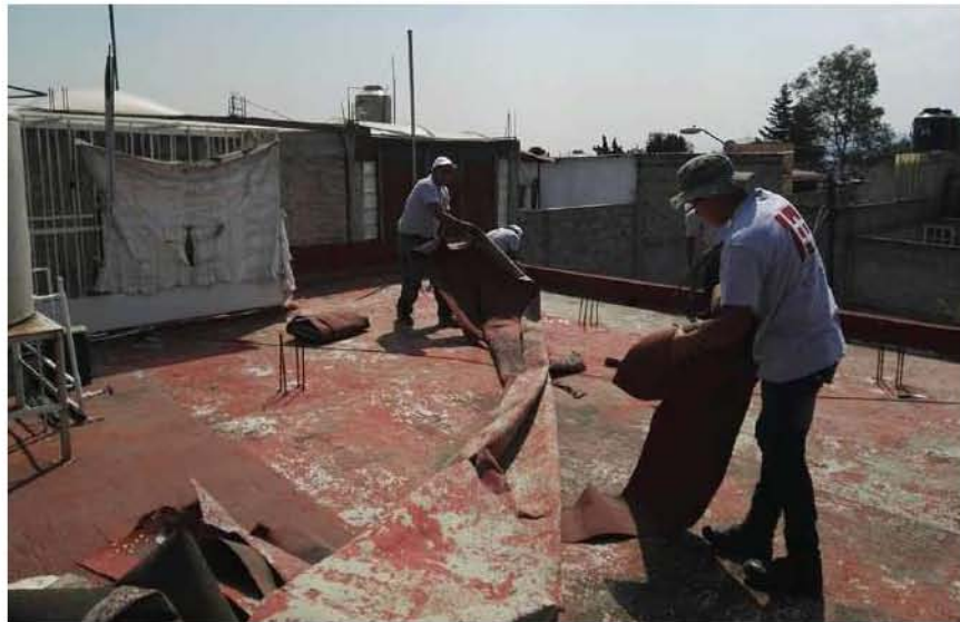
Gráfico 4.5.2 Proceso de mantenimiento de azotea en vivienda popular. Fuente: Fotografía propia.
