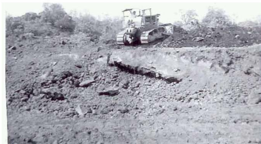
Gráfico 4.1.3 Fotografía que muestra el trabajo realizado sobre el terreno natural y la piedra volcánica para poder habitar el lugar. Fuente: Víctor Ávalos.
