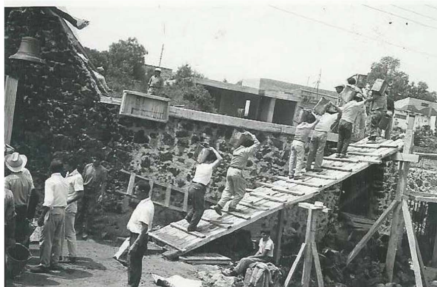
Construcción de la Iglesia de Tlalcoligia en 1961, realizada por los vecinos organizados. Fuente: Ignacio Sánchez Pérez (niño sentado en la parte inferior de la fotografía).
