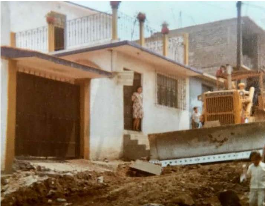
Gráfico 4.3.10 Fotografía de dos casas de la calle Otomíes en 1977, donde se puede ver el diferente nivel de consolidación material de cada una, al tiempo en que se realizaba la pavimentación del arrollo vehicular. Fuente: Ana María Velázquez Medina.
