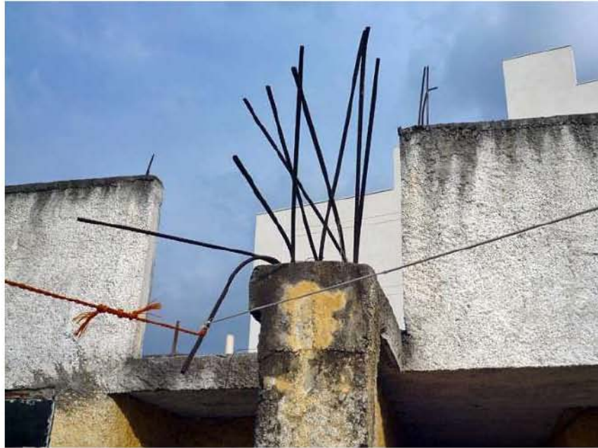
Gráfico 3.4.3 Se tiene siempre la esperanza de continuar con la ampliación de la vivienda, dejando dispuestas varillas para que en el momento que se requiera se pueda continuar con la construcción de la estructura. Fuente: Google.com
