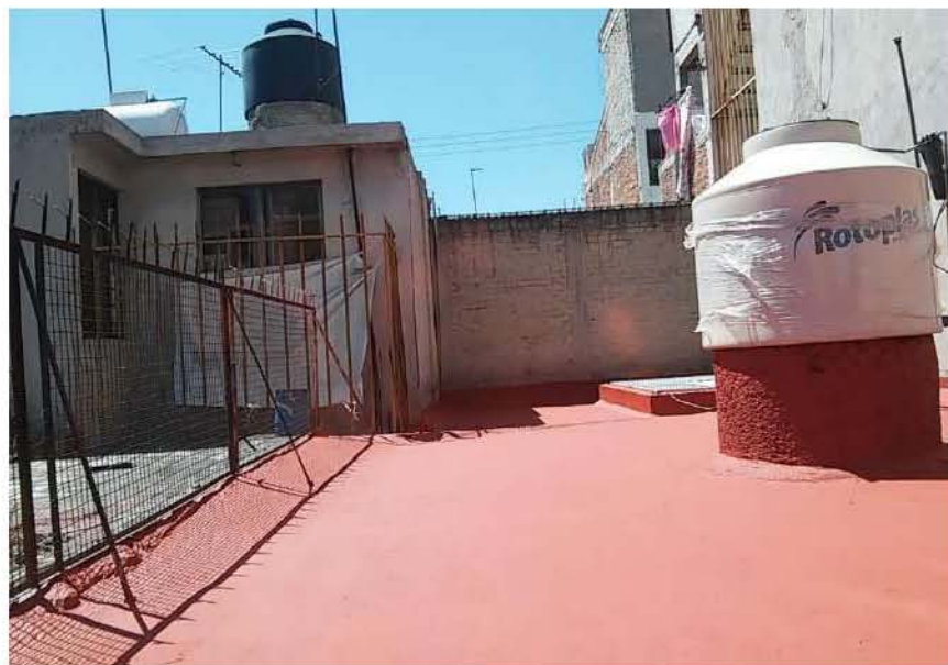
Gráfico 4.5.3 Proceso de mantenimiento de azotea en vivienda popular. Fuente: Fotografía propia.
