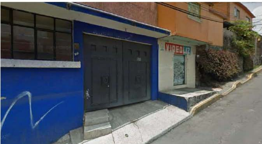
Gráfico 3.5.4 Banquetas obstruidas por plataformas, escaleras, rampas y demás elementos que evitan su apropiado uso peatonal. Fuente: Fotografía propia.
