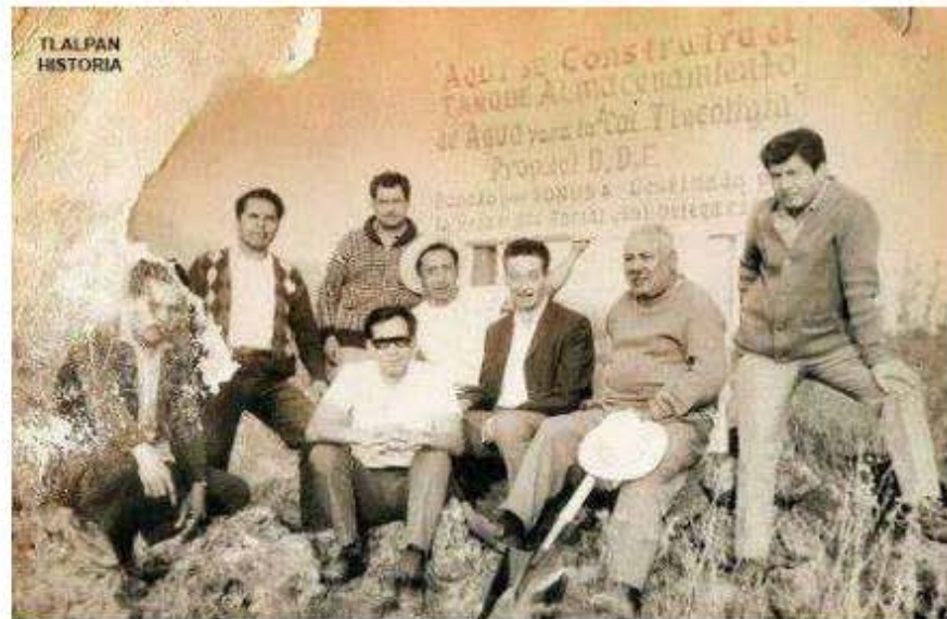
Gráfico 2.6.5 Fotografía de la construcción del pozo de agua. Fuente: Facebook Tlalpan Historia.
