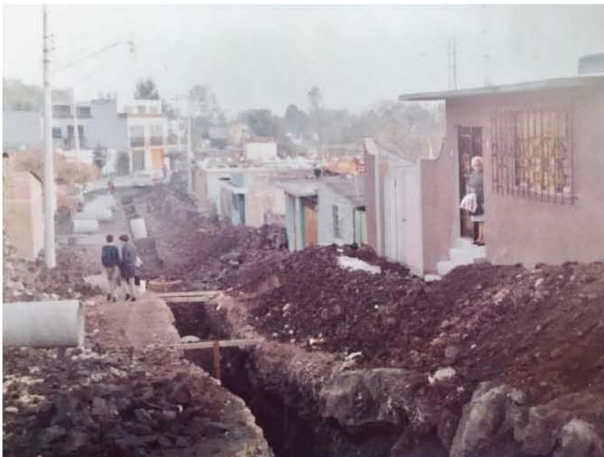
Gráfico 2.4.6 Fotografía de la construcción del drenaje en 1973 sobre la calle Otomías.
