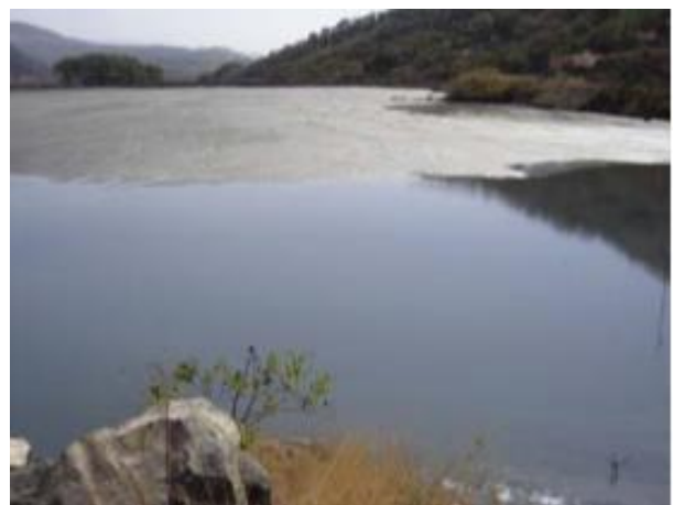
Figura 1.2b. Presa de jales que recibe el agua de flotación y los sólidos residuales o ganga, mezcla conocida como jales (Pacheco-Gutiérrez, 2006)
