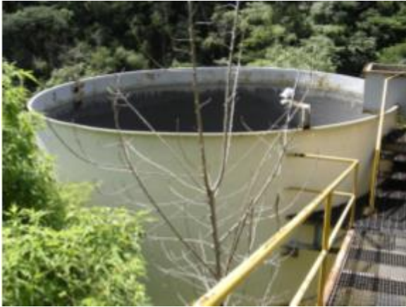
Figura 1.2c. Tanque de agua de reproceso bombeada desde la presa de jales (Pacheco-Gutiérrez, 2006).
