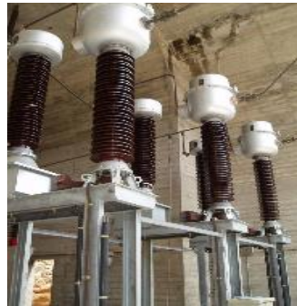
Figura 1.17. Ejemplo de interruptor de potencia.
