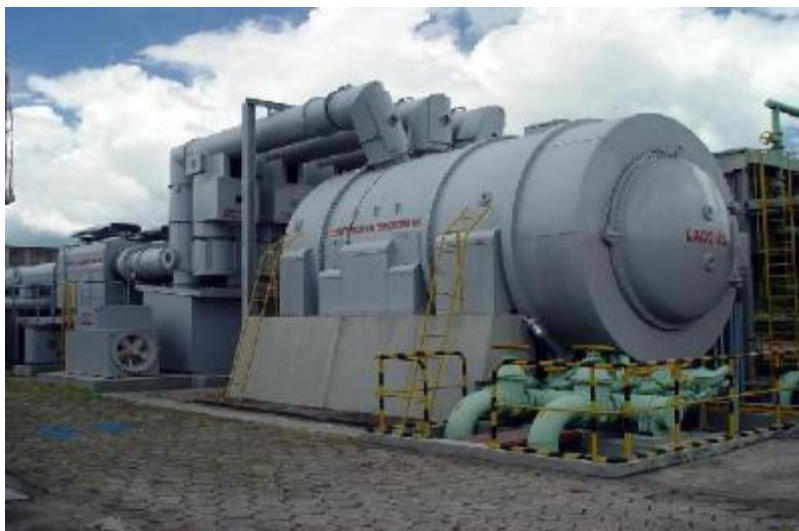
Figura 2.6. Ejemplo de condensador síncrono.
