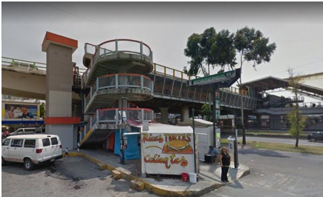
Línea B del metro, estación Ecatepec
